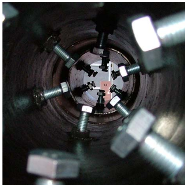
Abb.52: Rohrverbindung Ostendorf PVC-KG, bei einem Außenüberdruck von 2,0 bar. Kein Wassereintritt.
