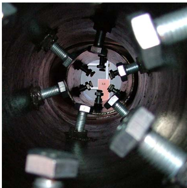
Abb.53: Rohrverbindung Ostendorf PVC-KG, bei einem Außenüberdruck von 3,0 bar. Kein Wassereintritt.
