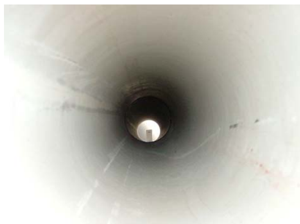
Abb.88: Rohrverbindung der Saint Gobain Gussrohr GmbH, Typ Integral Muffenrohr, bei einem Außenüberdruck von 3,0 bar. Kein Wassereintritt.
