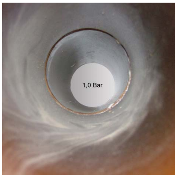
Abb.44: Rohrverbindung Euroceramic Eurotrade DN 150, bei einem Außenüberdruck von 1,0 bar. Kein Wassereintritt.
