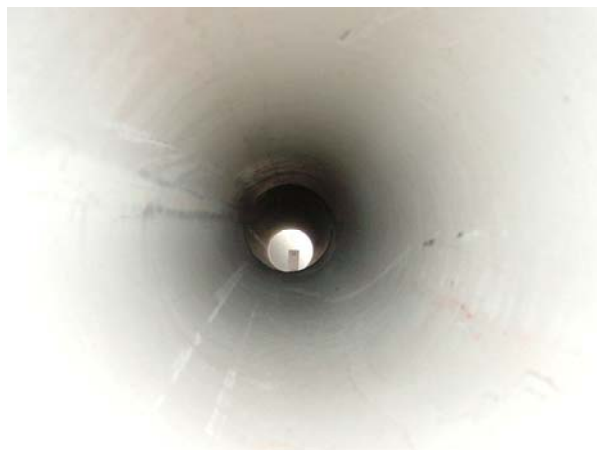
Abb.87: Rohrverbindung der Saint Gobain Gussrohr GmbH, Typ Integral Muffenrohr, bei einem Außenüberdruck von 2,0 bar. Kein Wassereintritt.
