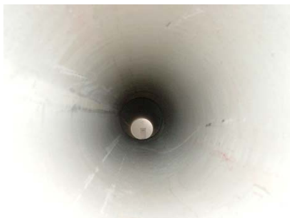
Abb.89: Rohrverbindung der Saint Gobain Gussrohr GmbH, Typ Integral Muffenrohr, bei einem Außenüberdruck von 4,0 bar. Kein Wassereintritt.
