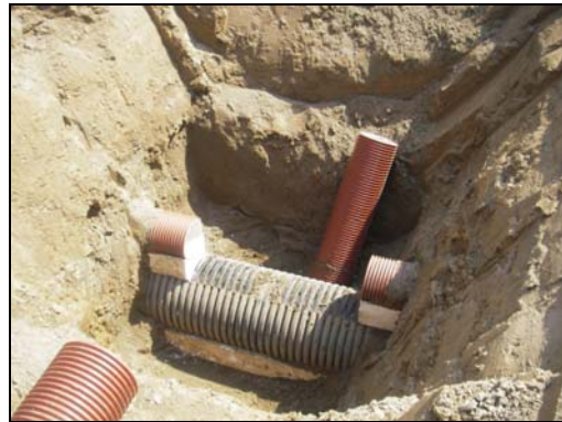
d) Vorbereiteter Rohrabschnitt
