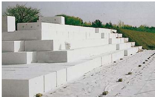
a) EPS für den Bau von Lärmschutzwällen
