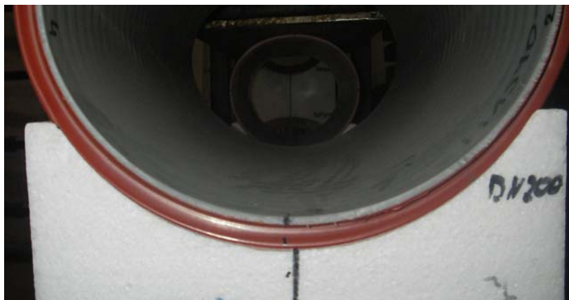
Bild 38 Entlastung des Sohlbereiches infolge Ovalisierung – Ultra-Rib II, DN 200
