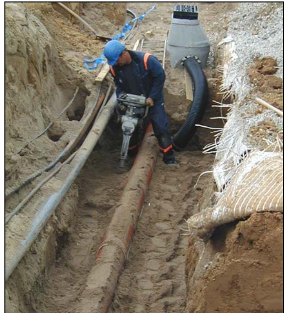
b) Verdichtung mittels Motorstampfer
