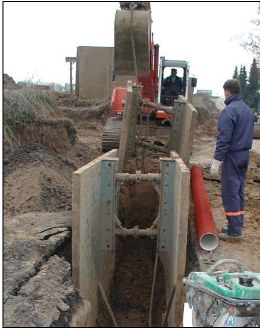
a) mit Baugrubensicherung
