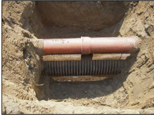
a) Freigelegter Rohrabschnitt
