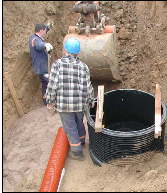
b) ohne Baugrubensicherung
