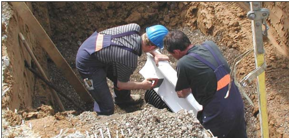
Bild 68 Zuschneiden der EPS-Kissen auf der Baustelle
