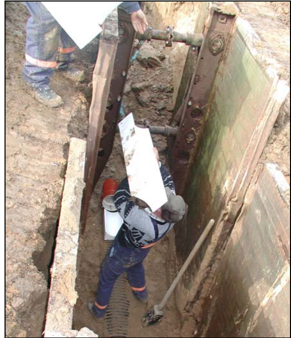
Bild 67 Transport und Einbringen der EPS-Kissen in die Baugrube
