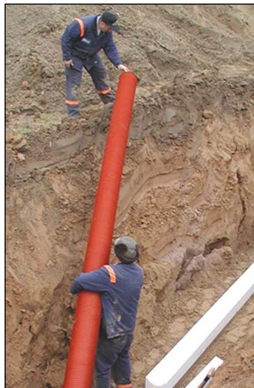
Bild 70 Handhabung von Kunststoffrohren auf der Baustelle
