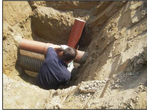
b) Heraustrennen des Rohrabschnittes
