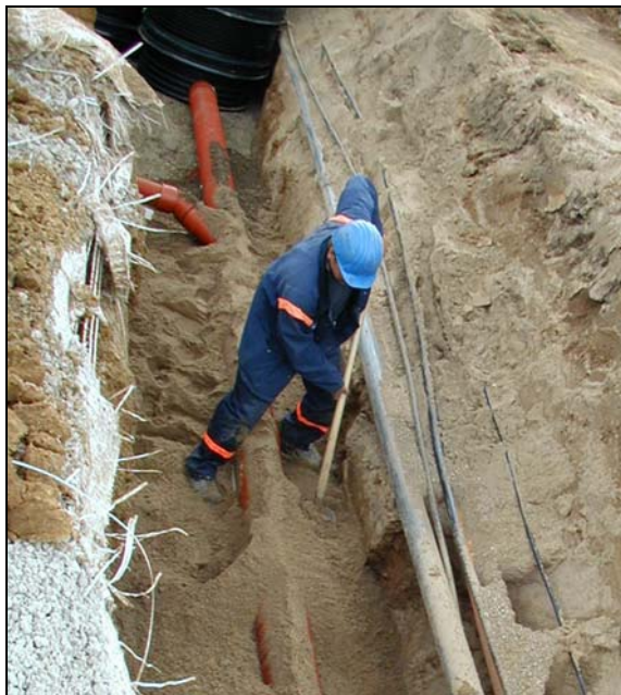
a) Verteilen des Bodens mittels Schaufel
