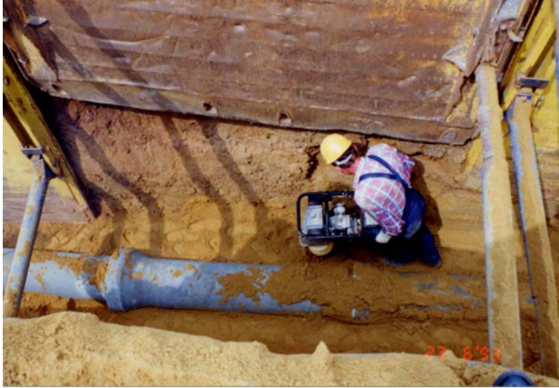
Bild 4 Anschüttung bis zur Höhe des Kämpfers und anschließende Verdichtung
