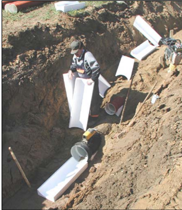
Bild 67 Transport und Einbringen der EPS-Kissen in die Baugrube
