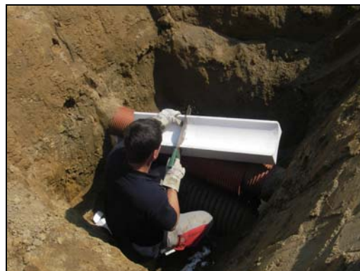
f) Zuschneiden des neuen EPS-Kisses
