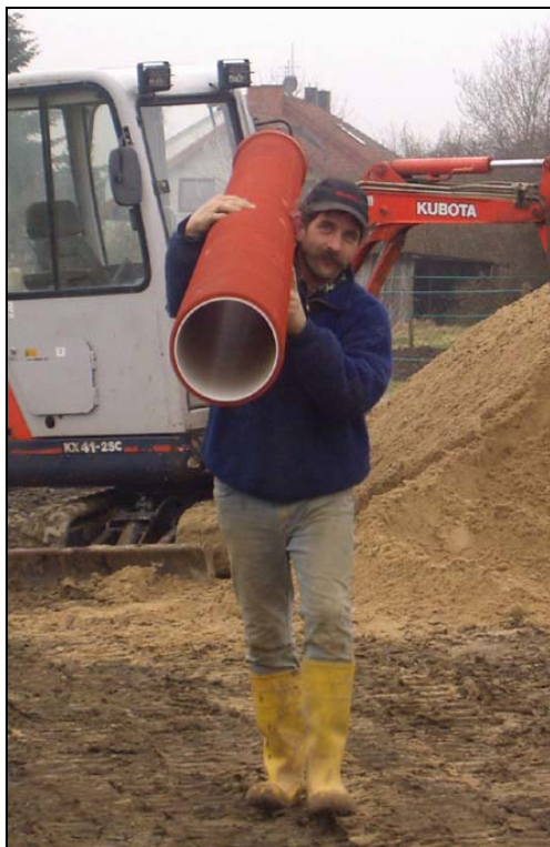
Bild 70 Handhabung von Kunststoffrohren auf der Baustelle
