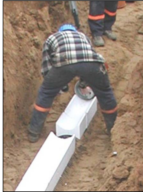
Bild 69 Verlegung der EPS-Kissen auf der Baustelle
