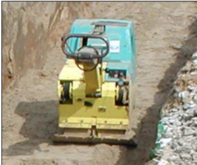
Bild 72 Eingesetztes Verdichtungsgerät: Rüttelplatte
