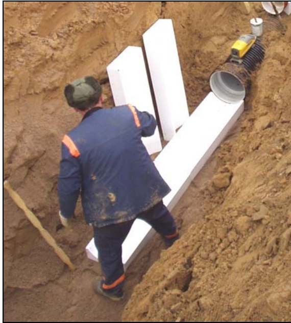
Bild 69 Verlegung der EPS-Kissen auf der Baustelle
