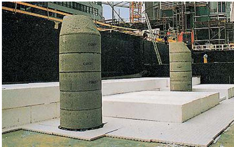
Bild 10 EPS für den Ausgleich von Höhenunterschieden im Erdbau [16]
