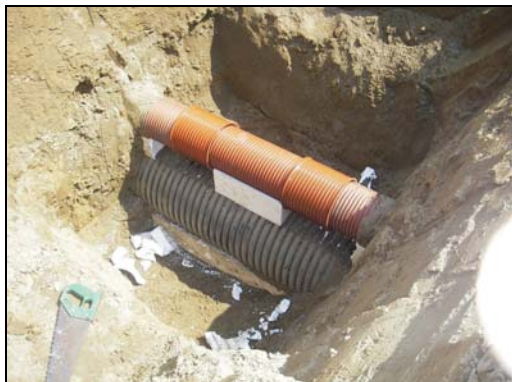
g) Fertiggestellter Rohrabschnitt
