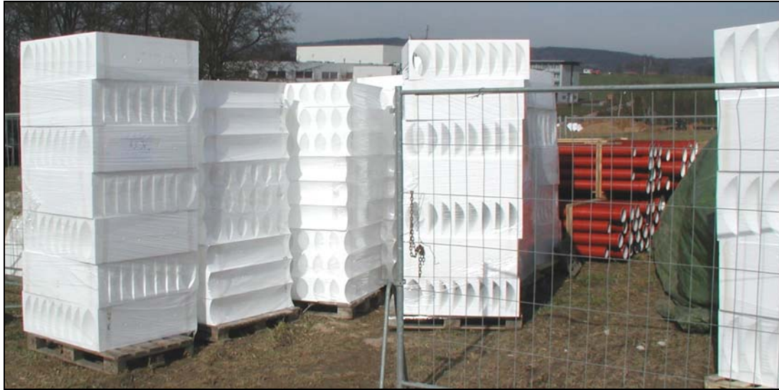
Bild 65 Lagerung von EPS-Bettungskissen auf der Baustelle
