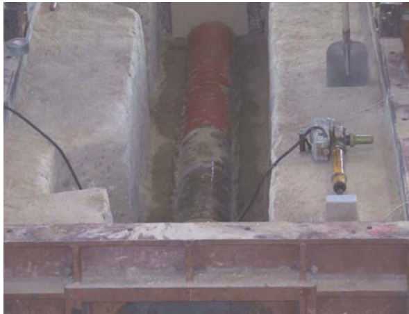
a) Eingebaute Bettungsschicht
