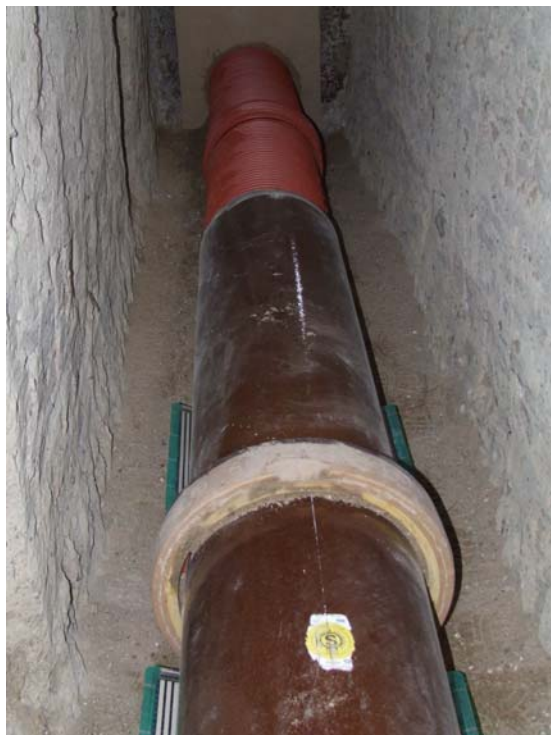
Bild 56 Einlagiger Rohrstrang auf EPS-Kissen mit Druckmessfolieneinsatz, Abschnitt 1 Steinzeug und Abschnitt 2 UltraRib II
