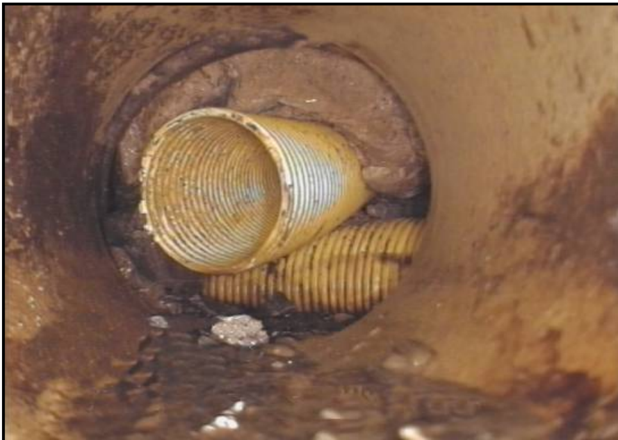
Abbildung 1-1: unerlaubter Dränageanschluss an öffentlichen Kanal, gelbes flexibles Rohr zur Baudränage, nicht fachgerecht geplant und errichtet (Quelle: Gemeinde Möhnensee)
