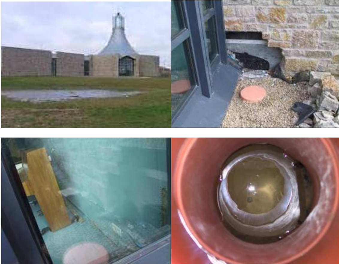
Abbildung 6-3: Beispiele aus Würzburg, die die Nicht-Eignung von Dränagen in den betroffenen Gebieten verdeutlichen,
