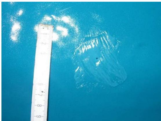
Bild 102 Oldodur-Beschichtung ohne Grundwassereinwirkung: Pinhole in der Beschichtung (links) und geringfügig fehlendes Beschichtungsmaterial im Bereich einer Steigbügelseinbindung (rechts)
