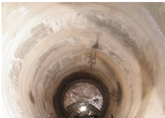
Bild 121 Abdichtungsergebnis: Feuchteindrang in den Schacht (links); Detailaufnahme der tiefer liegenden Undichtigkeiten (rechts)
