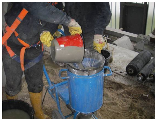
Bild 161 Abdichtung der Rohranbindungen mittels Zementleiminjektion: Wassereindrang durch offenen Packer (links), Befüllen der Injektionspumpe mit Zementleim (rechts)
