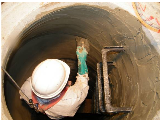
Bild 10 Mörtelbeschichtung: Auftrag von Hand (links), beschichteter Schacht (rechts)
