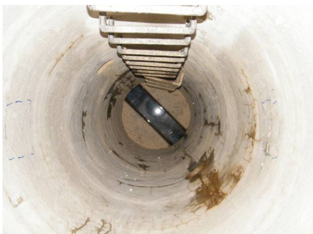
Bild 59 Blick in den Schacht mit trockener Berme
