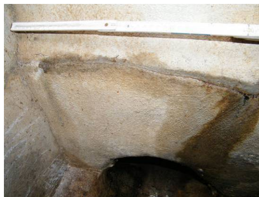
Bild 25 Zustandsveränderung einer Beschichtung innerhalb von drei Jahren: Risse in der Beschichtung mit Feuchtfahnen im Ausgangszustand (links) und Risse in der Beschichtung mit Ablösung und Wassereindrang nach drei Jahren (rechts)
