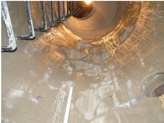
Bild 49 Beschichtung unter Grundwassereinfluss: Ausdehnung der Feuchtigkeit auf der Beschichtung (links), Detailbild eines Risses mit weißen Ausblühungen (rechts)
