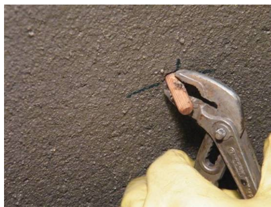
Bild 40 Temporäre Abdichtung der vorab eingebauten Schadstellen mit Holzdübeln: Lage der Schadstellen im Schacht (links); Entfernen des Dübels vor der Sanierung (rechts)
