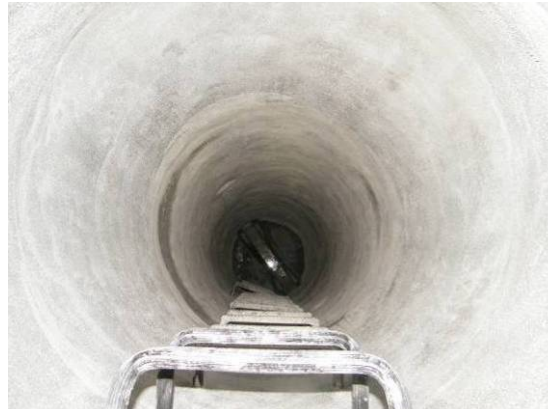
Bild 62 Aufsprühen eines Verdunstungsschutzes auf die Beschichtung (links), Blick in den beschichteten Schacht (rechts)
