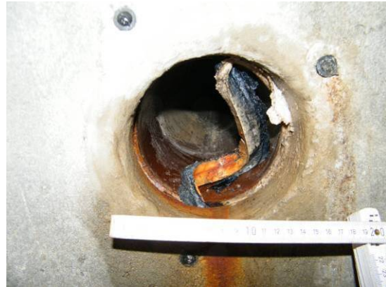
Bild 159 Undichte Steinzeug-Rohranbindung DN 150: Feuchtefahne und Fließspur mit Verfärbung beginnend im Sohlbereich (links), vollständig losgelöstes Acrylatgel im Ringraum, auf der Rohraußenseite schwarz verfärbt (rechts)
