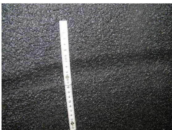
Bild 89 Kontrolle der Beschichtung ohne Grundwassereinwirkung: Rauhe Beschichtungsoberfläche im Bereich einer Schachtringfuge (links), Beschichtung im Schachtunterteil (rechts)
