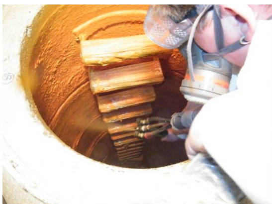
Bild 95 Aufsprühen des Beschichtungsmaterials im Schachtkonus (links), Blick in den beschichteten Schacht (rechts)
