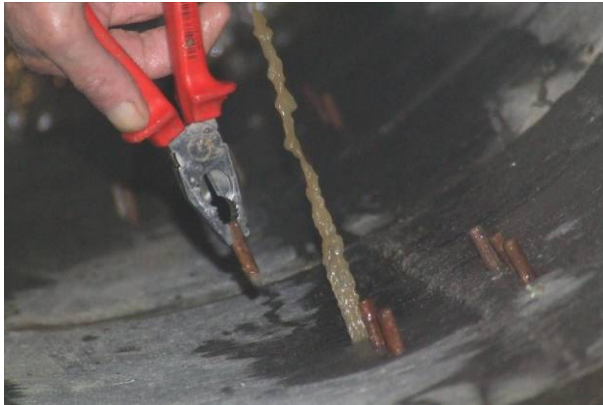
Bild 41 Wassereindrang durch die Schadstellen: Entnahme der Holzdübel (links) und Messung der infiltrierenden Wassermenge (rechts)
