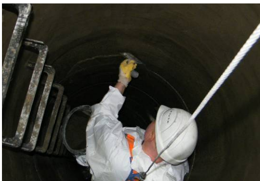
Bild 75 Auftragen des Mörtels (links), Blick in den beschichteten Schacht (rechts)
