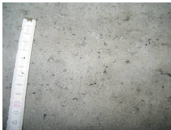
Bild 67 Hochdruckwasserstrahlen mit Heißwasser mittels handgeführter Lanze (links), Ergebnis der Untergrundvorbereitung (rechts)
