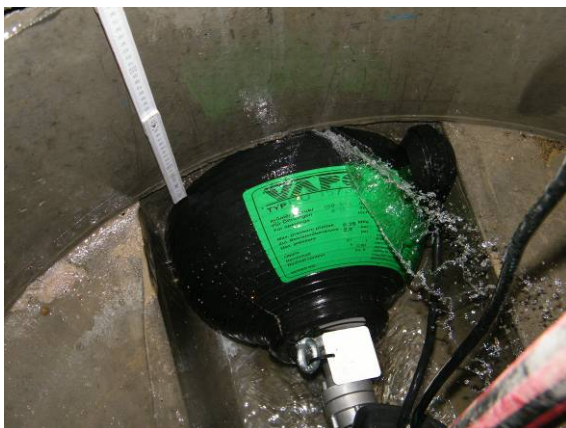
Bild 42 Undichte Rohranbindung DN 300 mit Wassereindrang durch Schadstellen, Absperrblase wurde bei Sanierung entfernt (links); Starker Wassereindrang unmittelbar nach dem Entfernen der Blase (rechts)
