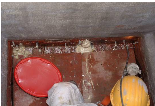
Bild 21 Injektionsverfahren bei einem Einsatz im Sohlbereich: Packer in der Schachtwand und eingetretenes Injektionsgut (links) und Beispiel für eine Injektionspumpe (rechts)
