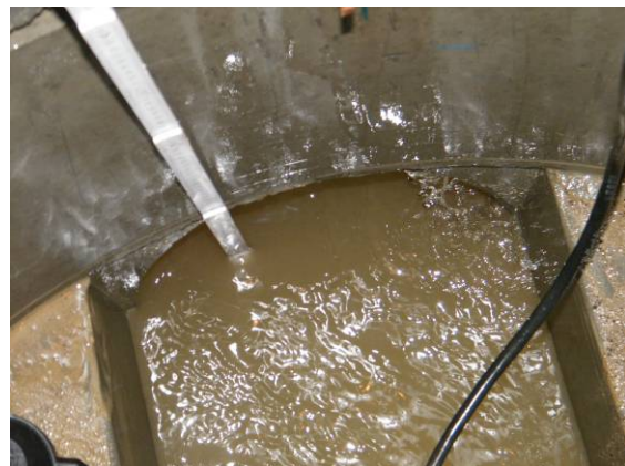
Bild 42 Undichte Rohranbindung DN 300 mit Wassereindrang durch Schadstellen, Absperrblase wurde bei Sanierung entfernt (links); Starker Wassereindrang unmittelbar nach dem Entfernen der Blase (rechts)
