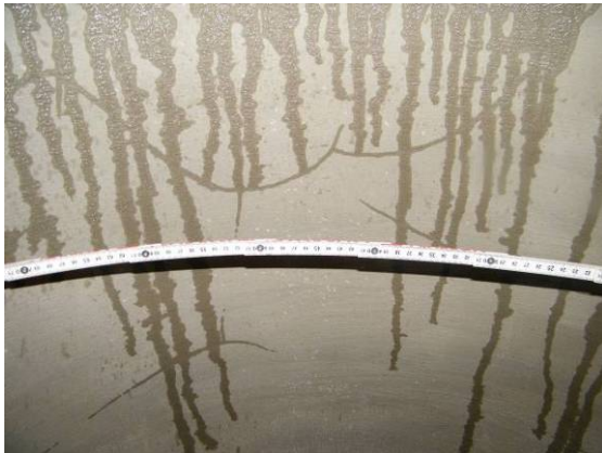
Bild 48 Zustand der Beschichtung ohne Grundwassereinwirkung: Risse erkennbar nach Befeuchten der Beschichtungsoberfläche mit Wasser (links), Detailbild eines Risses innerhalb einer Hohlstelle (Rissverlauf mit roten Pfeilen angezeigt, rechts)
