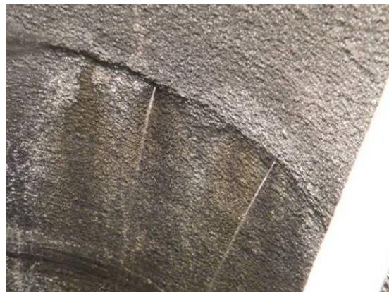
Bild 90 Autoschicht-Beschichtung unter Grundwassereinwirkung: Undichtigkeiten in allen Schachtringfugen (links), Detailaufnahme einer Ringfuge mit Wassereindrang (rechts)
