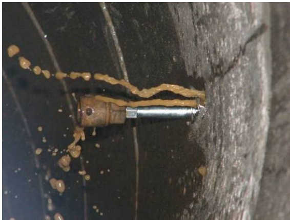
Bild 139 Injektion von Polyurethanharz: Wassereindrang im Umfeld des Packers an noch nicht abgedichteten Stellen innerhalb der Schadstelle FU 2 (links); abgedichtete Schadstelle FU 2 nach der Injektion (rechts)
