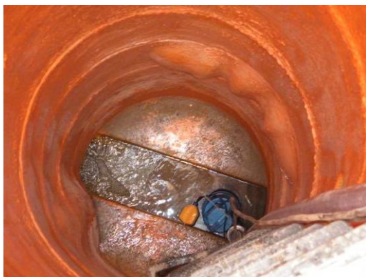
Bild 169 Polymere Beschichtungen in Bereichen, an denen der Verbund mit Trennmittel planmäßig geschwächt wurde: Blasenbildung mit fortschreitender Ablösung (links) und Aufreißen der Beschichtung (rechts)
