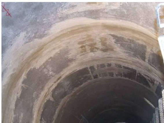
Bild 127 Abdichtung mit einem kristallbildnerhaltigen Mörtel: Verfüllte Ringfugen in der Schachtwand (links); Aufquaste der Schlämme (rechts)
