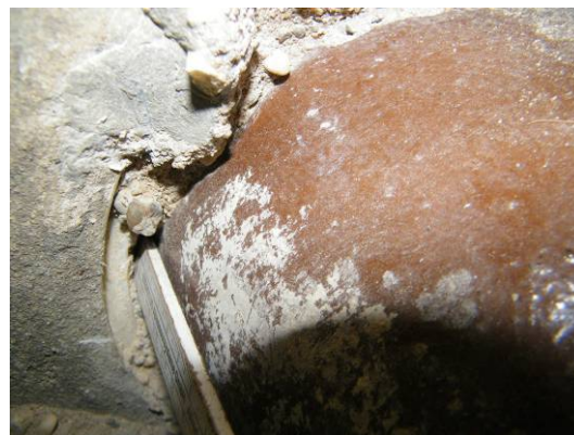
Bild 163 Zementleim-Injektionskörper am Anschlussbereich des Kunststoffrohres DN 150 mit erkennbarem Spalt zwischen Rohr und Injektionskörper (links), linke Kämpferseite des Steinzeugrohrs DN 150 ohne umgebendes Injektionsmaterial (rechts)
