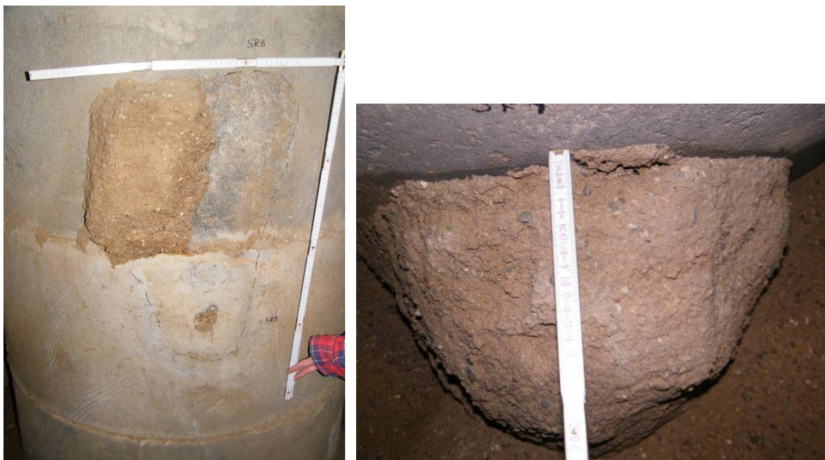
Bild 147 Acrylatgel-Injektionskörper, nur noch im linken Bereich als Teil des Ursprungskörpers anhaftend, Packerloch im unteren Bereich sichtbar (links); weiterer Injektionskörper, noch im unteren Bereich eingerdet und mit deutlichen Ablösungen im oberen Bereich (rechts)
