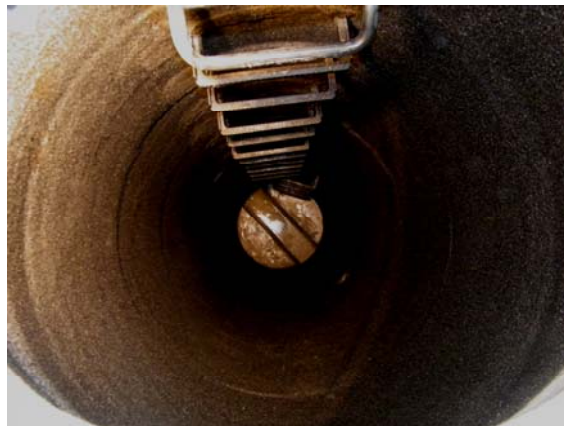
Bild 88 Schleudermotor während der Beschichtung (links), Blick in den beschichteten Schacht (rechts)
