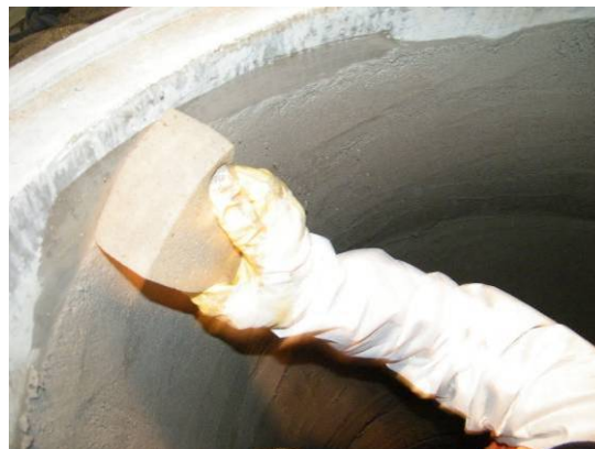
Bild 61 Auftragen des Beschichtungsmörtels (links), Abreiben der Mörteloberfläche mit einem Schwamm (rechts)
