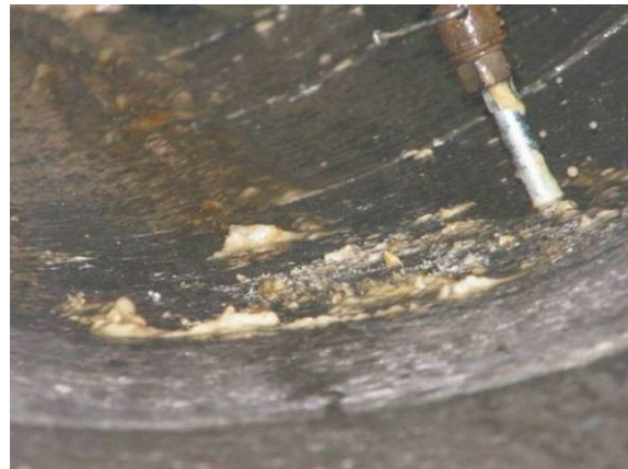
Bild 139 Injektion von Polyurethanharz: Wassereindrang im Umfeld des Packers an noch nicht abgedichteten Stellen innerhalb der Schadstelle FU 2 (links); abgedichtete Schadstelle FU 2 nach der Injektion (rechts)
