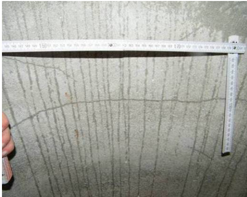
Bild 63 Beschichtung ohne Grundwassereinwirkung nach Befeuchten der Oberfläche: Risse in der Beschichtung im Bereich einer unplanmäßigen Hohlstelle (links), Riss im Bereich einer Hohlstelle aus planmäßiger Verbundschwächung durch Trennmittel (FU 4, rechts)
