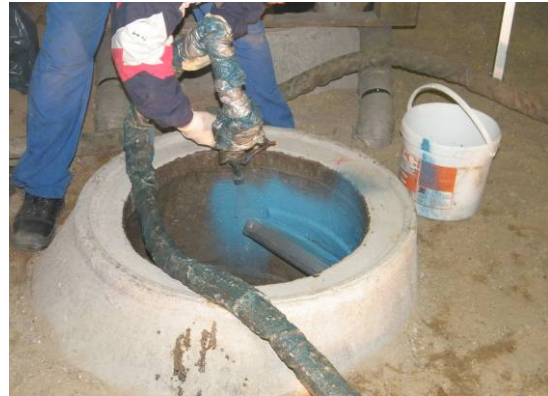
Bild 100 Aufstreichen des Primers auf die Schachtwand (links), Beschichtungsauftrag mittels handgeführter Sprühdüse (rechts)
