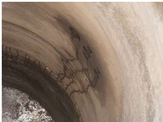
Bild 121 Abdichtungsergebnis: Feuchteindrang in den Schacht (links); Detailaufnahme der tiefer liegenden Undichtigkeiten (rechts)
