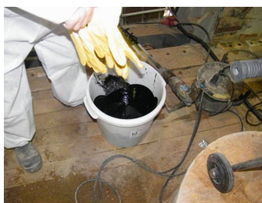
Bild 87 Baustelleneinrichtung für Beschichtungsarbeiten (links), Anmischen des Beschichtungsmaterials vor Befüllen der Förderpumpe (rechts)
