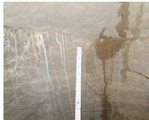
Bild 57 KS-ASS-Beschichtung unter Grundwassereinwirkung: Risse im Bereich einer Hohlstelle aus planmäßiger Verbundschwächung durch Trennmittel mit weißen Ausblühungen (links) und Beispiel für Risse und Feuchtefahnen im Bereich einer unplanmäßigen Hohlstelle (rechts)
