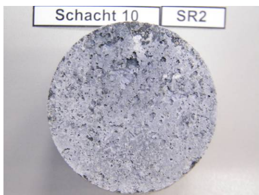
Bild 66 Bruchstelle, exemplarisch für ein vollständiges Versagen in der Verbundfuge
