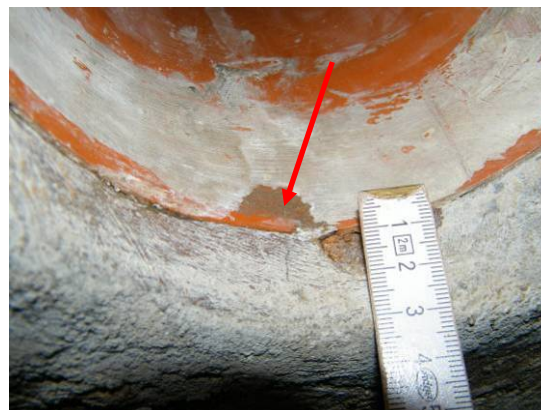
Bild 157 Ergebnisse der Abdichtungsarbeiten an den Seitenzuläufen DN 150: Wassertropfen hängt an einragendem Injektionsmaterial (vgl. roter Pfeil, links), Wasser dringt durch einen Riss zwischen Mörtelverdämmung und Rohrspiegel ein (vgl. roter Pfeil, rechts)
