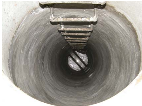
Bild 81 Abreiben der Beschichtung mit einem feuchten Schwamm (links), Blick in den beschichteten Schacht (rechts)
