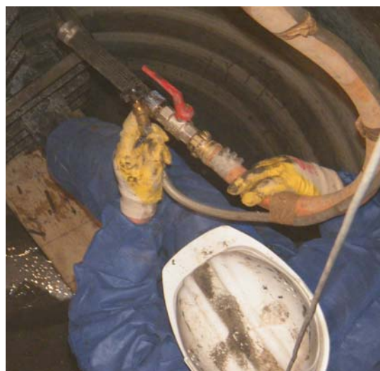
Bild 80 Materialauftrag von Hand mittels Kelle und Glätter (links) und im Nassspritzverfahren (rechts)
