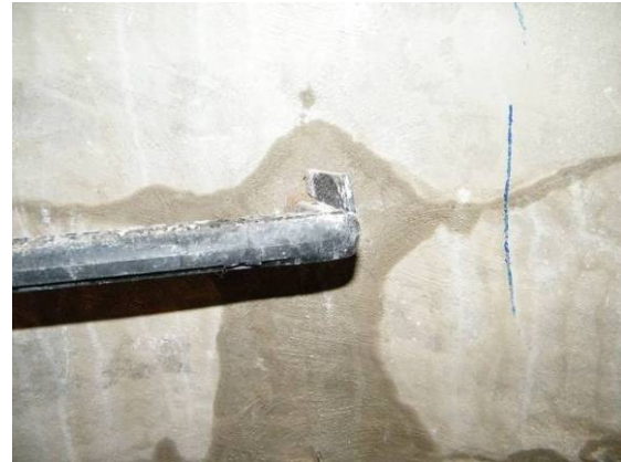
Bild 56 KS-ASS-Beschichtung unter Grundwassereinwirkung: Netzartige Risse im Bereich einer Schachtringfuge (links) und Beispiel für eine Feuchtefahne auf der Beschichtung im Einbindebereich eines Steigbügels (rechts)
