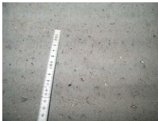
Bild 52 Maschinelle Untergrundvorbereitung mittels rotierender Reinigungsdüsen (links), Ergebnis der Untergrundvorbereitung (rechts)
