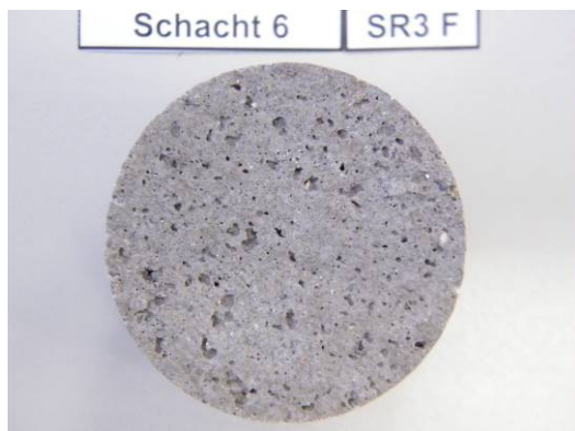
Bild 78 Bruchstelle, exemplarisch für ein vollständiges Versagen in der Verbundfuge
