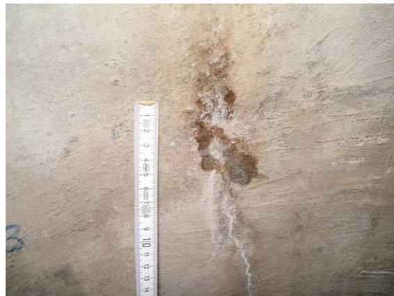
Bild 123 Abdichtungsergebnis mit Mörteln: Feuchtestellen in den unteren Bereichen des Schachtes an SF 3 (links) und LS 3 (rechts)
