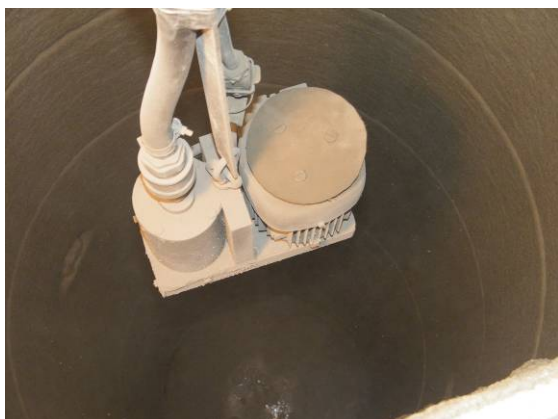
Bild 11 Mörtelbeschichtung: Anschleuderverfahren (links), beschichteter Schacht (rechts)
