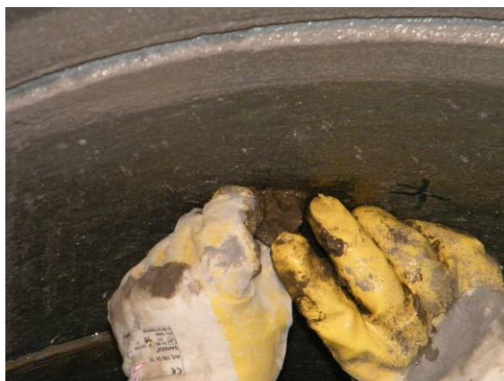
Bild 120 Mörtelabdichtung: Eindrücken des Reparaturmörtels von Hand in die Schachtringfuge (links); Eindrücken von Stopfmörtel in die Schadstelle (rechts)
