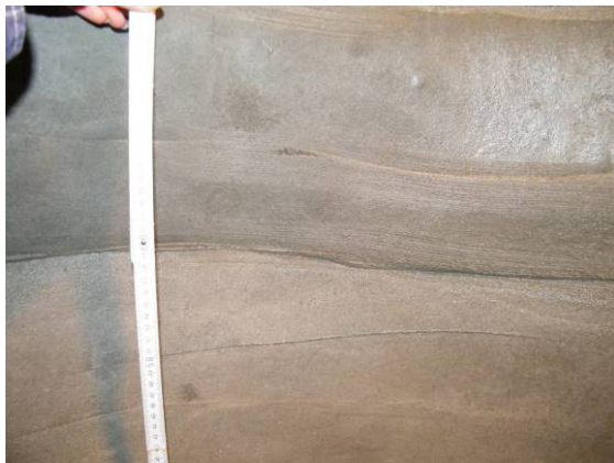
Bild 71 Feuchtigkeit auf der Beschichtung (links); innerhalb der roten Markierung zeigte sich nach dem Abschlagen der obersten Mörtellage eine trockene Beschichtung (rechts)
