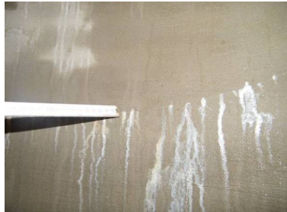
Bild 49 Beschichtung unter Grundwassereinfluss: Ausdehnung der Feuchtigkeit auf der Beschichtung (links), Detailbild eines Risses mit weißen Ausblühungen (rechts)
