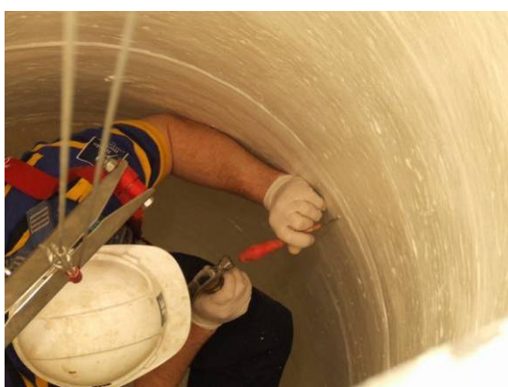
Bild 115 Kontrolle der Beschichtung und Nachbearbeiten einzelner Fehlstellen (links), Blick in den beschichteten Schacht (rechts)
