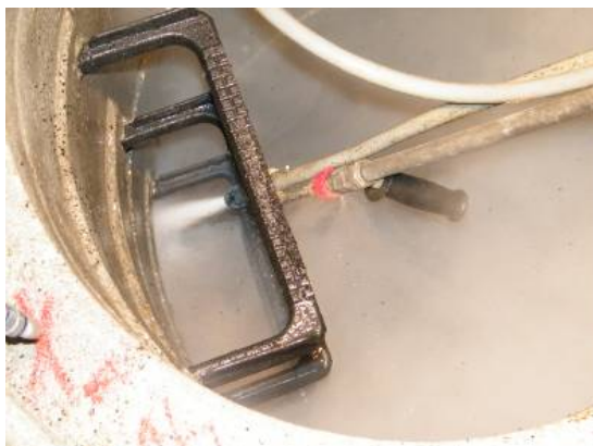
Bild 45 Wasser-Feststoff-Strahlen mit Hochdruck und Heißwasser mittels handgeführter Lanze (links), Ergebnis der Untergrundvorbereitung (rechts)
