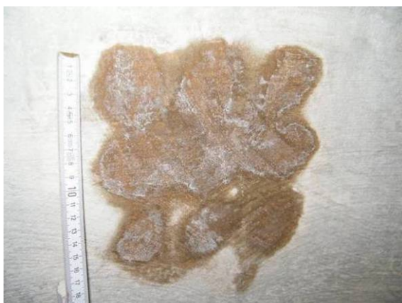
Bild 128 Änderung der farblichen Ausprägung und Ausdehnung derselben Schadstelle innerhalb von ca. 13 Wochen: Anfangs größere Ausdehnung sowie dunklere Verfärbung der Schadstelle (links) und geringere Ausdehnung und farblich hellere Ausprägung nach 13 Wochen (rechts)
