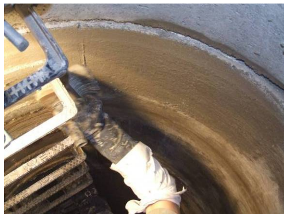
Bild 127 Abdichtung mit einem kristallbildnerhaltigen Mörtel: Verfüllte Ringfugen in der Schachtwand (links); Aufquaste der Schlämme (rechts)
