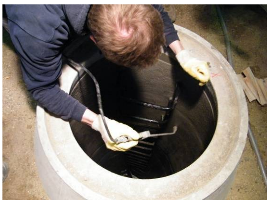
Bild 62 Aufsprühen eines Verdunstungsschutzes auf die Beschichtung (links), Blick in den beschichteten Schacht (rechts)
