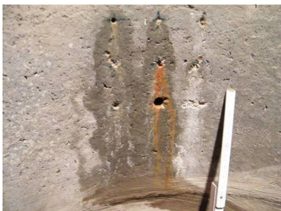
Bild 141 Feuchtefahnen und Eintrag von bräunlichem, minderfesten Material an der sanierten Schadstelle FU 6 etwa sieben Wochen nach der Abdichtung (links) und nach etwa dreizehn Wochen (rechts)
