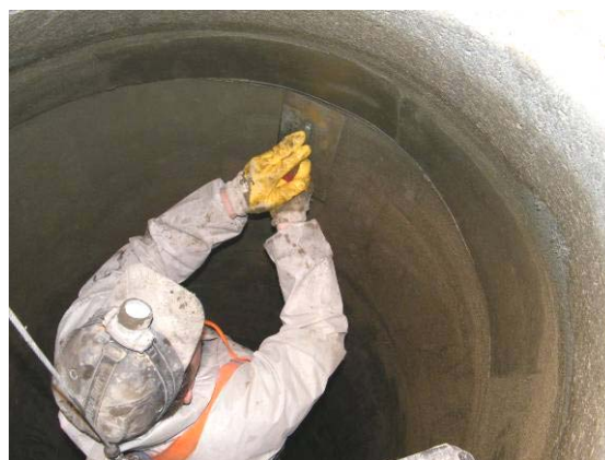
Bild 68 Auftragen der Haftbrücke mittels Quast (links), Glätten der Beschichtung nach dem Auftragen des Mörtels (rechts)
