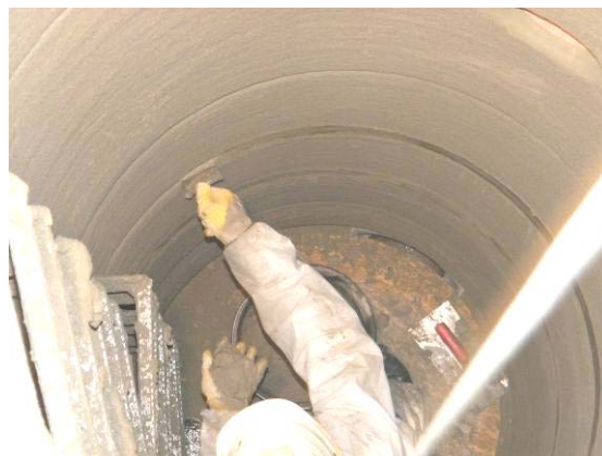
Bild 53 Schleudermotor während der Beschichtung (links), händisches Nachbearbeiten der Beschichtung im Bereich der Schachtringfugen (rechts)
