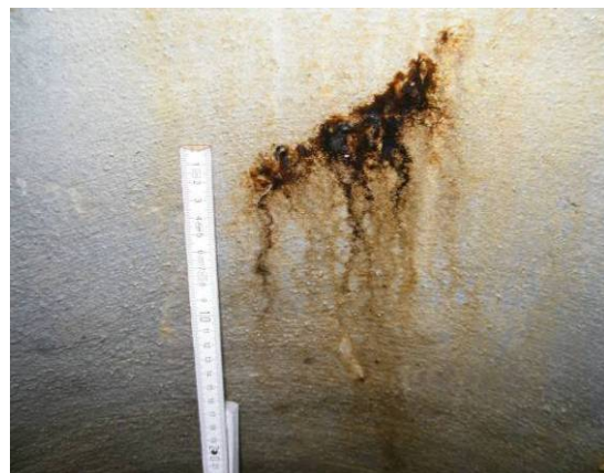
Bild 65 Beschichtung unter Grundwassereinwirkung: Geringfügiger Wassereindrang an der linken Einbindestelle des vierten Steigbügels von unten (links), Schmutzanhaftungen auf der Beschichtung im Bereich eines Risses (rechts)
