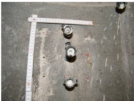
Bild 149 Erfolgreiche Abdichtung des Schadens FU 6 (links); Wassereindrang durch einen Packer im Bereich der Schachtringfuge 6 (rechts)
