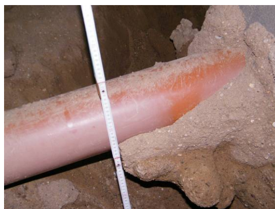
Bild 158 Acrylatgel-Injektionskörper an sanierten Rohranbindungsbereichen der Nennweite DN 150 aus Steinzeug (links) und PVC (rechts)
