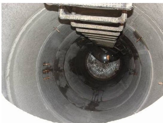
Bild 40 Temporäre Abdichtung der vorab eingebauten Schadstellen mit Holzdübeln: Lage der Schadstellen im Schacht (links); Entfernen des Dübels vor der Sanierung (rechts)
