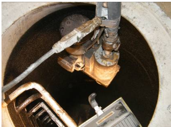
Bild 88 Schleudermotor während der Beschichtung (links), Blick in den beschichteten Schacht (rechts)
