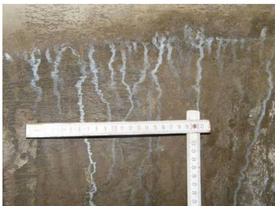
Bild 123 Abdichtungsergebnis mit Mörteln: Feuchtestellen in den unteren Bereichen des Schachtes an SF 3 (links) und LS 3 (rechts)
