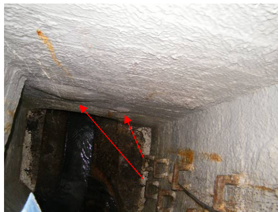
Bild 17 Mängel an polymeren Beschichtungen: Undichtigkeit (links) in einem Schacht aus [18] und Blasenbildung durch Ablösung der Beschichtung vom Untergrund (rechts)
