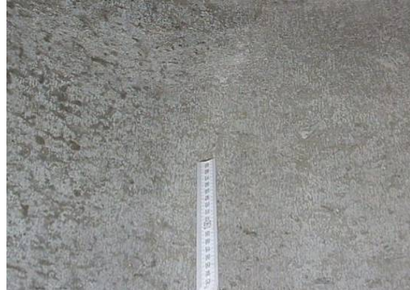
Bild 93 Hochdruckwasserstrahlen mit Heißwasser (links), Ergebnis der Untergrundvorbereitung (rechts)
