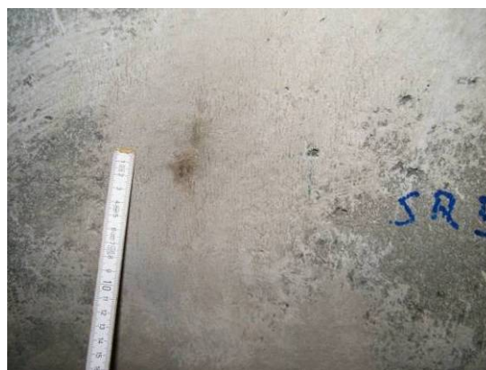
Bild 122 Abdichtungsergebnis mit Mörteln: Feuchtfahnen an den höher liegenden Reparaturstellen des Schachtes in SF 5 (links) und LS 5 (rechts)
