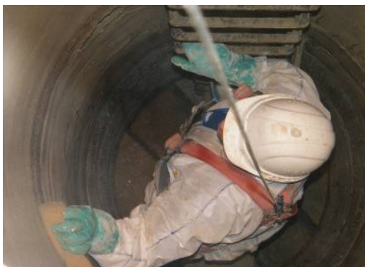
Bild 47 Abreiben der Mörteloberfläche mit einem Schwamm (links), Blick in den beschichteten Schacht (rechts)
