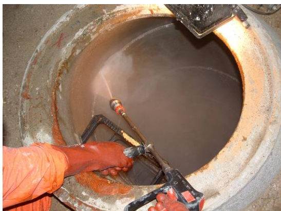
Bild 79 Untergrundvorbereitung mittels Hochdruckwasser-Strahlen (links), Ergebnis der Untergrundvorbereitung (rechts)
