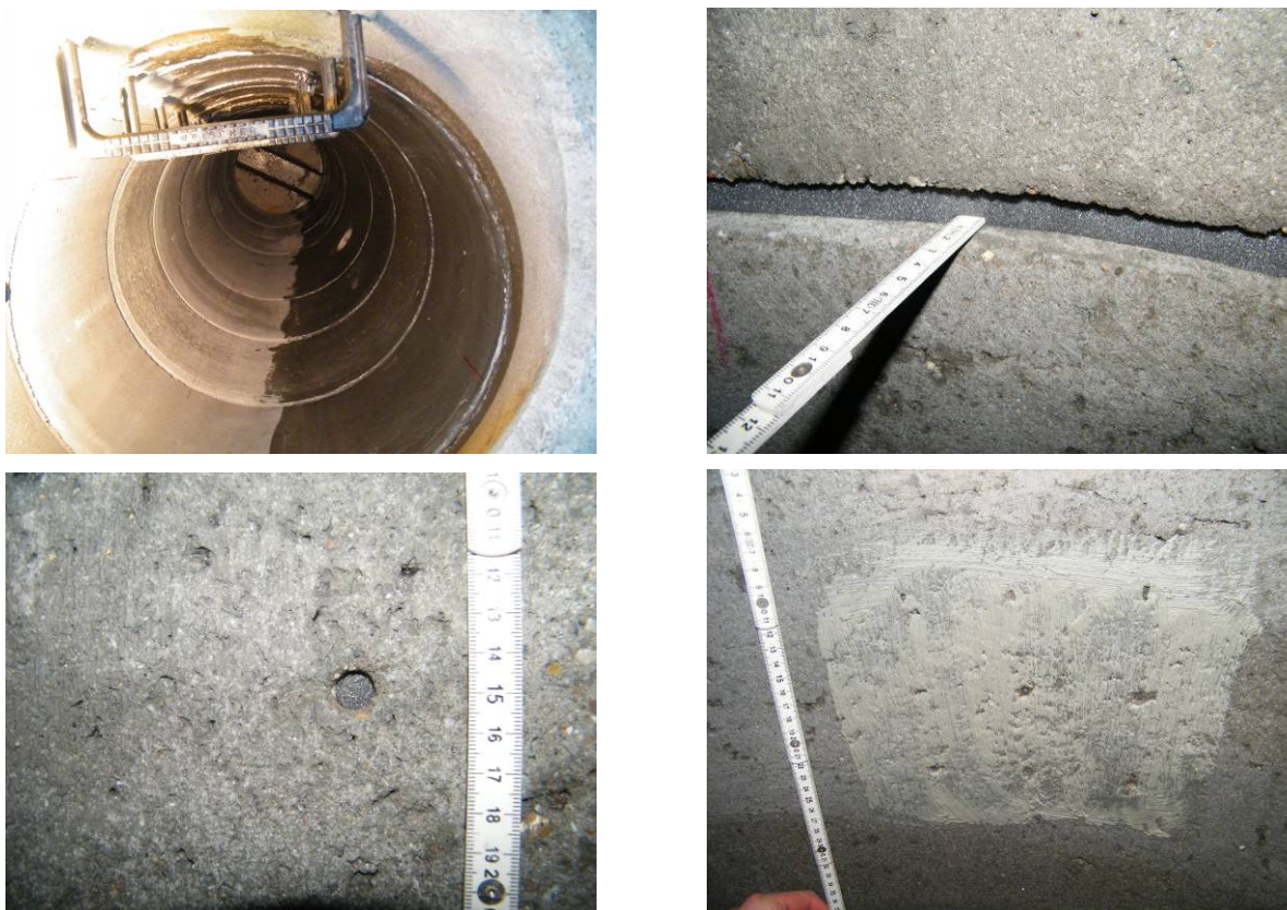
Bild 39 Versuchstechnische Besonderheiten bei der Schachtbeschichtung: halbseitig eingefetteter Schacht (links oben); Schaumstoff in einer Ringfuge (rechts oben); Schaumstoff-Pfropfen in einem Bohrloch (links unten); aufgestrichenes Trennmittel (rechts unten)
