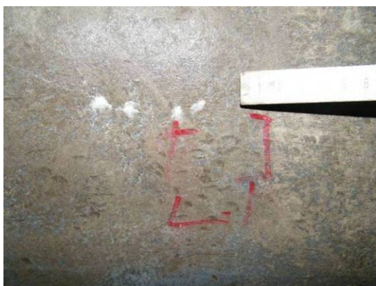
Bild 76: Beschichtung unter Grundwassereinwirkung: Weiße Ausblühungen an einem Riss im Bereich einer Hohlstelle aus planmäßiger Verbundschwächung durch Trennmittel (FU 2) ohne Feuchteindrang (links) und mit geringer Feuchtefahne (rechts)
