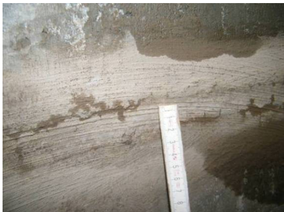
Bild 140 Beispiel für einen Feuchteintrang an der abgedichteten Schachtringfuge SF 5: Nach Trocknen des Bereichs wurde eindringendes Wasser aus einem Riss in der Verdämmung sichtbar (links); vollständig ausgebildete Feuchtefahne an dieser Stelle (rechts)
