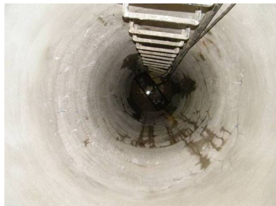
Bild 50 Beschichtung unter Grundwassereinfluss mit Beispiel für eine geringere (links) und größere (rechts) Ausdehnung der Feuchtefahnen, Zustandsveränderung innerhalb von drei Wochen
