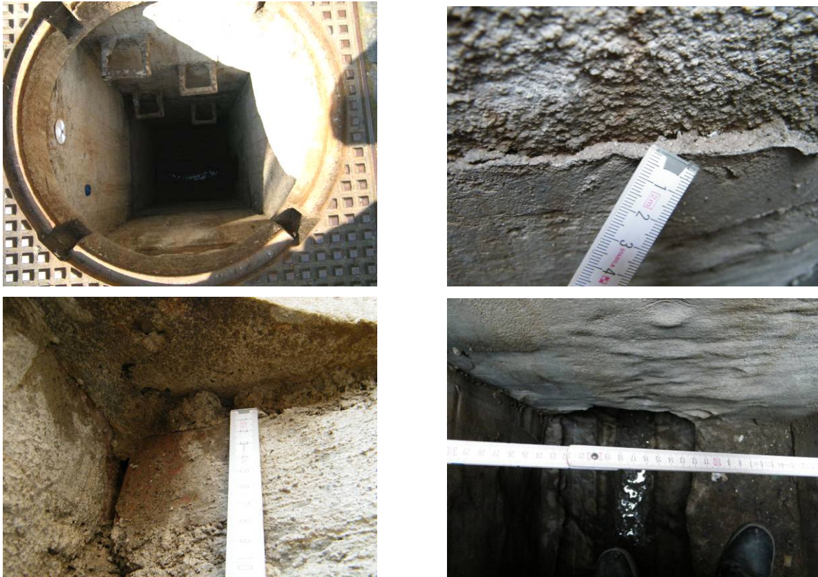
Bild 27 Schacht 1: Blick in den beschichteten Schacht (links oben); Übergangsbereich von Schlamm und Dickbeschichtung (rechts oben); unvollständiger Materialauftrag im oberen Bereich des Schachtes (links unten); wellige Struktur der Beschichtung (rechts unten)
