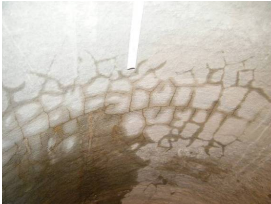
Bild 56 KS-ASS-Beschichtung unter Grundwassereinwirkung: Netzartige Risse im Bereich einer Schachtringfuge (links) und Beispiel für eine Feuchtefahne auf der Beschichtung im Einbindebereich eines Steigbügels (rechts)
