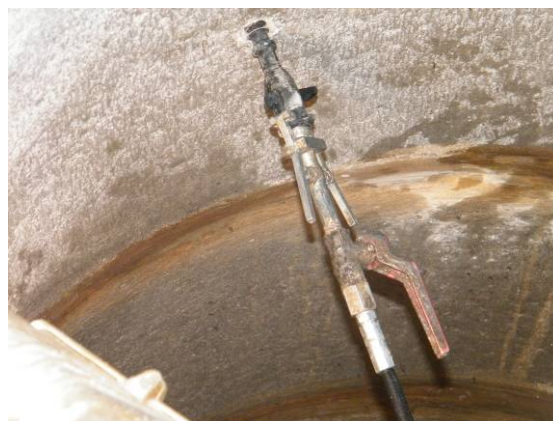
Bild 144 Einlegen einer Hinterfüllschnur in die Schachtringfuge (links); Verpressen einer einzelnen Schadstelle (rechts)
