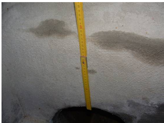
Bild 25 Zustandsveränderung einer Beschichtung innerhalb von drei Jahren: Risse in der Beschichtung mit Feuchtfahnen im Ausgangszustand (links) und Risse in der Beschichtung mit Ablösung und Wassereindrang nach drei Jahren (rechts)
