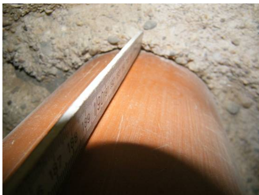
Bild 163 Zementleim-Injektionskörper am Anschlussbereich des Kunststoffrohres DN 150 mit erkennbarem Spalt zwischen Rohr und Injektionskörper (links), linke Kämpferseite des Steinzeugrohrs DN 150 ohne umgebendes Injektionsmaterial (rechts)
