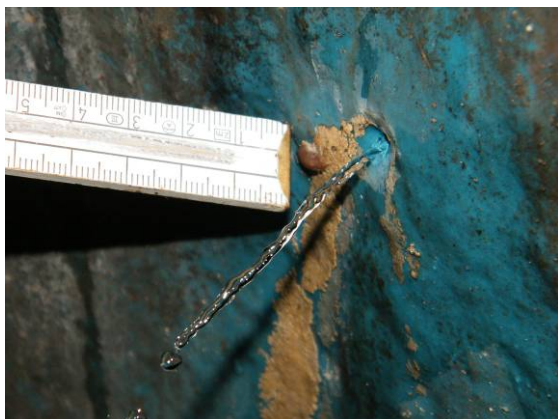
Bild 17 Mängel an polymeren Beschichtungen: Undichtigkeit (links) in einem Schacht aus [18] und Blasenbildung durch Ablösung der Beschichtung vom Untergrund (rechts)
