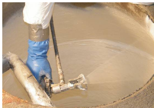
Bild 114 Beschichten der Ringfugen (links) und des Konus (rechts)
