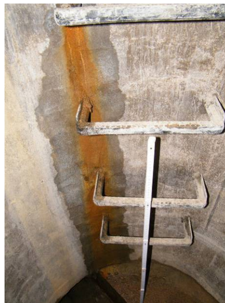
Bild 77 Beschichtung unter Grundwassereinwirkung: Abtropfendes Wasser, eingedrungen an dem linken Einbindebereich des vierten Steigbügels (links), Wasserfließspuren auf der Beschichtung bis in das Gerinne hinein (rechts)
