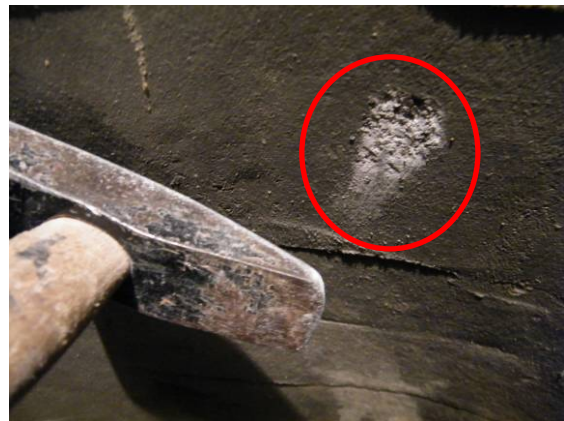
Bild 71 Feuchtigkeit auf der Beschichtung (links); innerhalb der roten Markierung zeigte sich nach dem Abschlagen der obersten Mörtellage eine trockene Beschichtung (rechts)
