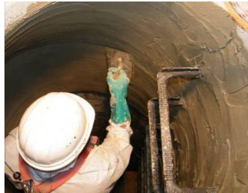
Bild 46 Vorbereitung für das Auftragen der Haftbrücke (links), Glätten der Beschichtung nach dem Auftragen des Mörtels (rechts)
