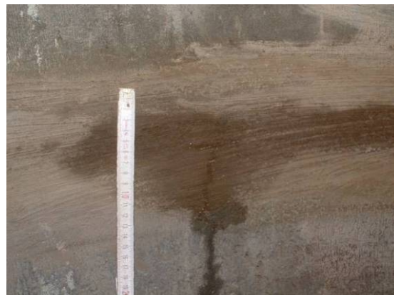
Bild 140 Beispiel für einen Feuchteintrang an der abgedichteten Schachtringfuge SF 5: Nach Trocknen des Bereichs wurde eindringendes Wasser aus einem Riss in der Verdämmung sichtbar (links); vollständig ausgebildete Feuchtefahne an dieser Stelle (rechts)
