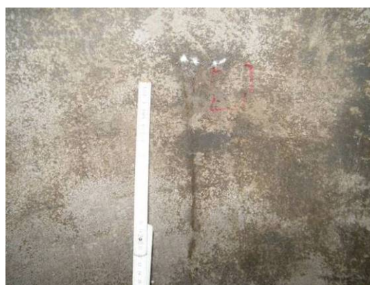
Bild 76: Beschichtung unter Grundwassereinwirkung: Weiße Ausblühungen an einem Riss im Bereich einer Hohlstelle aus planmäßiger Verbundschwächung durch Trennmittel (FU 2) ohne Feuchteindrang (links) und mit geringer Feuchtefahne (rechts)
