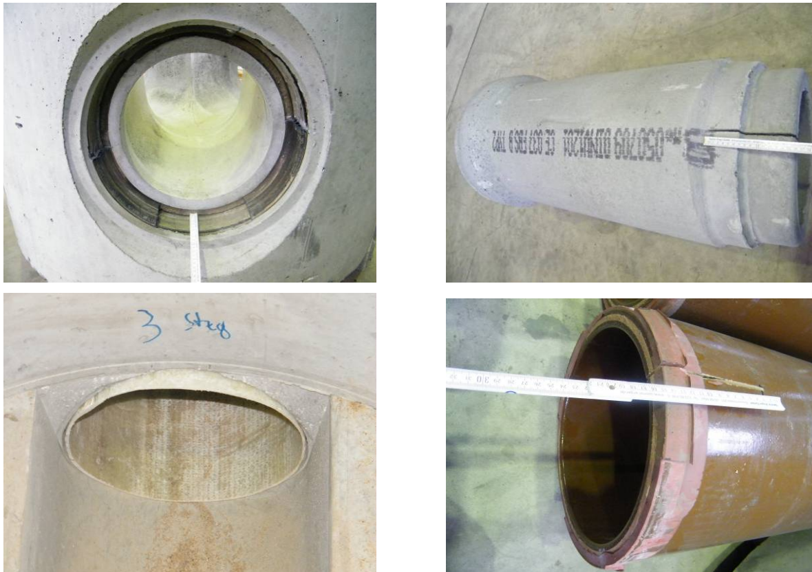
Bild 198 Schäden zur Simulation von Undichtigkeiten an Rohrverbindungen: Geschädigte Dichtung für Betonrohr (oben links); Längsschnitt im Betonrohrscheitel (oben rechts); Eingesetzter Liner mit offenem Ringspalt (unten links); Längsschnitt im Steinzeugrohrscheitel (unten rechts)
