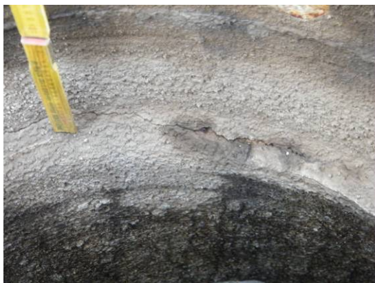
Bild 24 Beispiele von Rissen in der Beschichtung im Schachtkopfbereich: Gerissene Beschichtung unterhalb des Schachtrahmens (links) und Risse in der Beschichtung im Einstiegsbereich (rechts)
