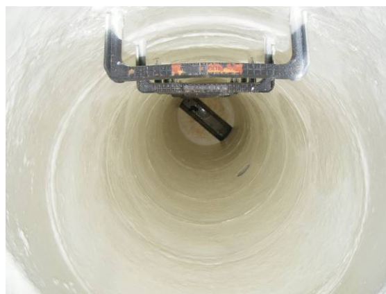
Bild 115 Kontrolle der Beschichtung und Nachbearbeiten einzelner Fehlstellen (links), Blick in den beschichteten Schacht (rechts)
