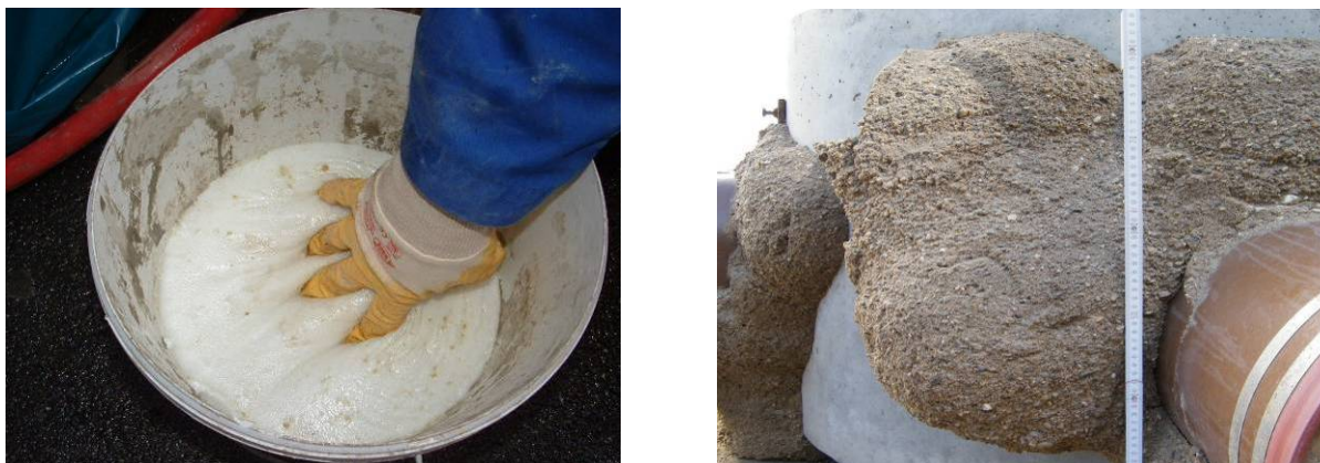
Bild 18 Injektionen auf Acrylharzbasis: Ausgehärtetes Gel (links) und Bodeninjektion (rechts)
