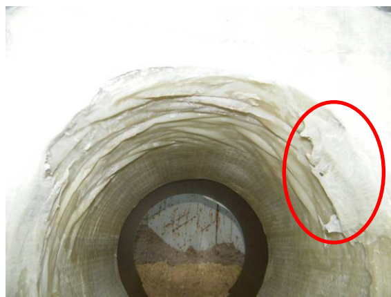
Bild 201 Wasseraustritt während der Kanalreinigung zwischen Rohr und Injektionskörper (links); Abgelöstes Handlaminat (innerhalb roter Markierung) führte zu einer Undichtigkeit (rechts)
