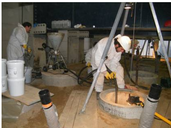
Bild 87 Baustelleneinrichtung für Beschichtungsarbeiten (links), Anmischen des Beschichtungsmaterials vor Befüllen der Förderpumpe (rechts)
