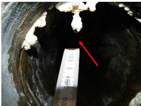
Bild 157 Ergebnisse der Abdichtungsarbeiten an den Seitenzuläufen DN 150: Wassertropfen hängt an einragendem Injektionsmaterial (vgl. roter Pfeil, links), Wasser dringt durch einen Riss zwischen Mörtelverdämmung und Rohrspiegel ein (vgl. roter Pfeil, rechts)
