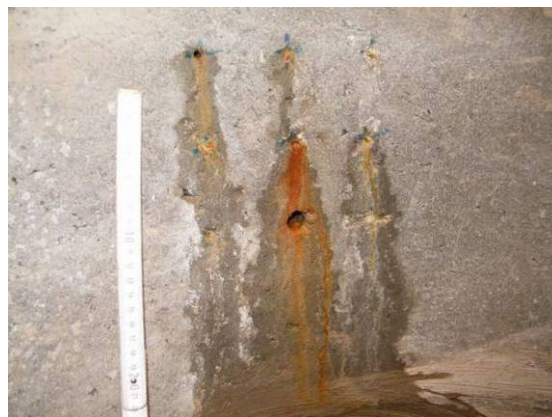
Bild 141 Feuchtefahnen und Eintrag von bräunlichem, minderfesten Material an der sanierten Schadstelle FU 6 etwa sieben Wochen nach der Abdichtung (links) und nach etwa dreizehn Wochen (rechts)
