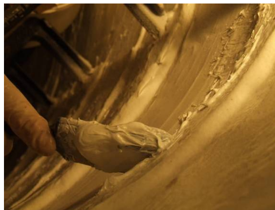
Bild 15 Anschleudern einer polymeren Beschichtung (links), Nacharbeiten einzelner Stellen mit einem Pinsel (rechts)
