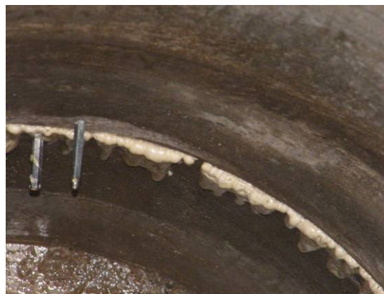
Bild 135 Bohren eines Packerlochs (links), ausgetretenes und ausreagiertes Polyurethanharz aus der verdämmten Schachtringfuge SF 2 (rechts)
