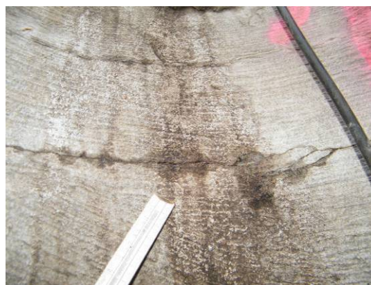
Bild 24 Beispiele von Rissen in der Beschichtung im Schachtkopfbereich: Gerissene Beschichtung unterhalb des Schachtrahmens (links) und Risse in der Beschichtung im Einstiegsbereich (rechts)
