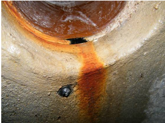
Bild 159 Undichte Steinzeug-Rohranbindung DN 150: Feuchtefahne und Fließspur mit Verfärbung beginnend im Sohlbereich (links), vollständig losgelöstes Acrylatgel im Ringraum, auf der Rohraußenseite schwarz verfärbt (rechts)
