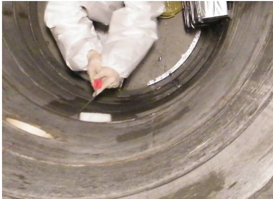
Bild 100 Aufstreichen des Primers auf die Schachtwand (links), Beschichtungsauftrag mittels handgeführter Sprühdüse (rechts)
