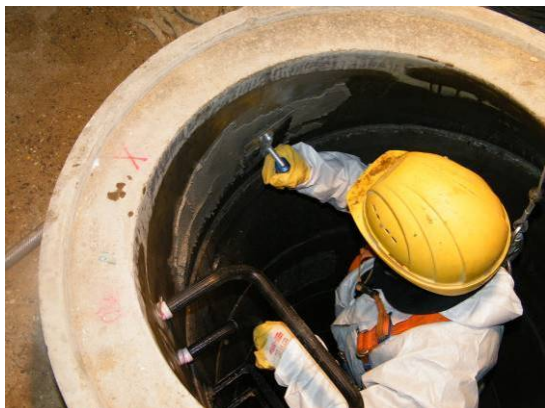
Bild 61 Auftragen des Beschichtungsmörtels (links), Abreiben der Mörteloberfläche mit einem Schwamm (rechts)
