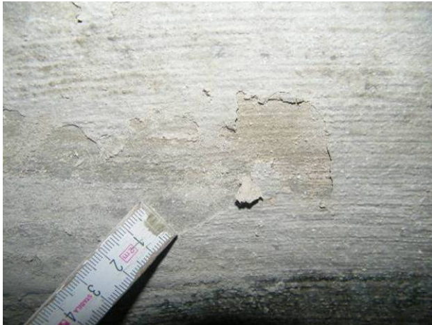
Bild 129 Minderfeste Mörtelschlämme kann mit einem Zollstock abgeschabt werden (links); bereichsweise dunkle Verfärbungen der Mörtelschlämme ohne erkennbare Undichtigkeiten (rechts)
