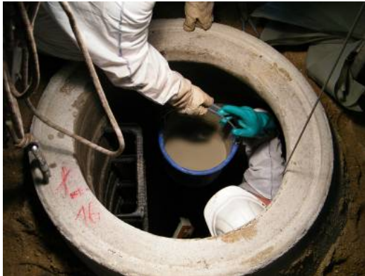
Bild 46 Vorbereitung für das Auftragen der Haftbrücke (links), Glätten der Beschichtung nach dem Auftragen des Mörtels (rechts)
