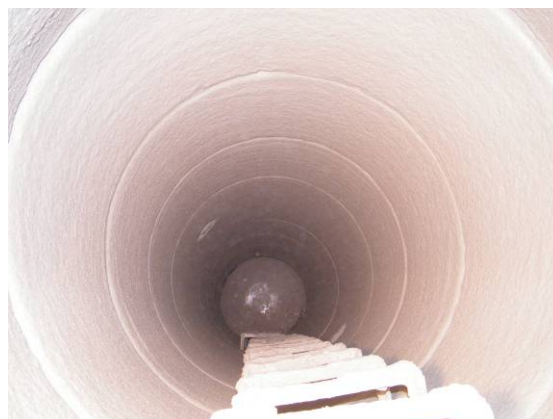
Bild 11 Mörtelbeschichtung: Anschleuderverfahren (links), beschichteter Schacht (rechts)
