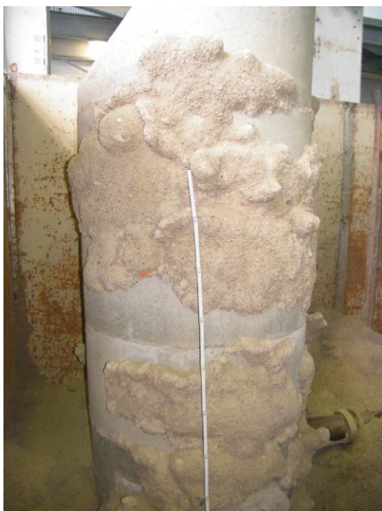
Bild 143 Polyurethan-Injektionskörper an der Schachtaußenseite (links), Detailaufnahme (rechts)
