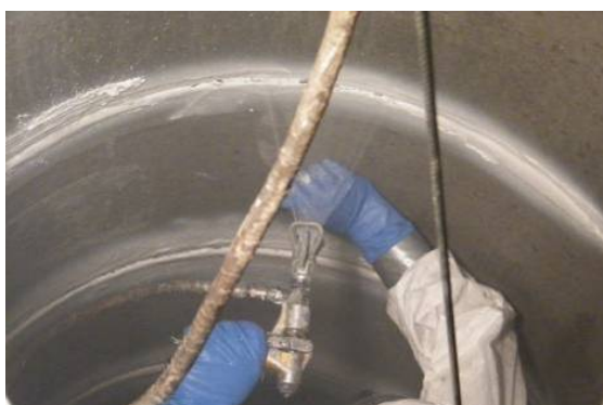
Bild 114 Beschichten der Ringfugen (links) und des Konus (rechts)
