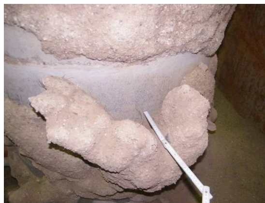
Bild 143 Polyurethan-Injektionskörper an der Schachtaußenseite (links), Detailaufnahme (rechts)
