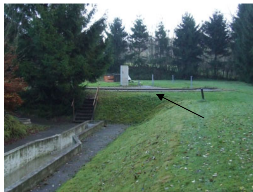
Abb. 34: Pufferbecken (Unterbau der ehemaligen Tropfkörperanlage)
