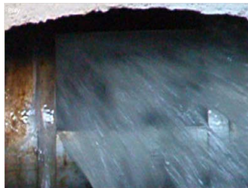
Abb. 27: Freispiegelkanal unmittelbar nach Anschlussstelle der Druckleitung – Spülschwallaustritt
