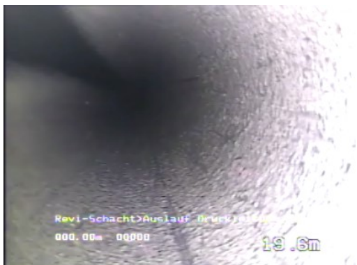
Abb. 105: Bildausschnitt – Inspektion in Fließrichtung vor Zugabe von „Lipolyt 2000“
