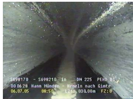
Abb. 19: Beispiel 2 – Inspektion nach der Reinigung
