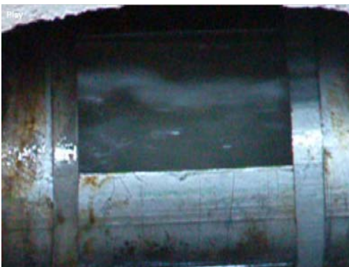
Abb. 26: Freispiegelkanal unmittelbar nach Anschlussstelle der Druckleitung - Grundabfluss während der Reinigung
