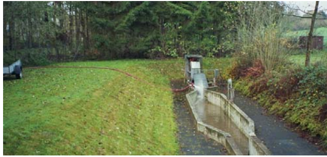
Abb. 39: Zuleitung des Bachwassers in den Sandfang
