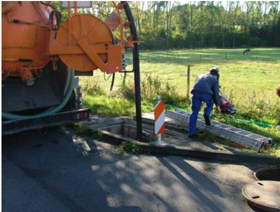
Abb. 24: Entleerung des Pumpenschachtes vor der Reinigung
