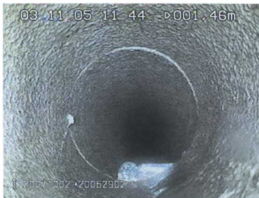
Abb. 83: TV-Inspektion vor der Reinigung, Bildausschnitt 1
