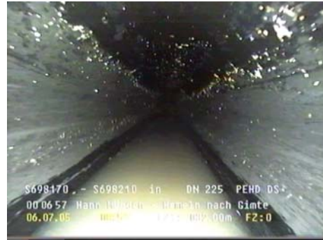
Abb. 17: Beispiel 1 – Inspektion nach der Reinigung
