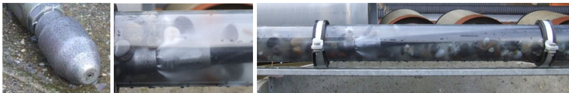
Abb. 168: Stocherdüse (Düse 1) in Kiesablagerungen
