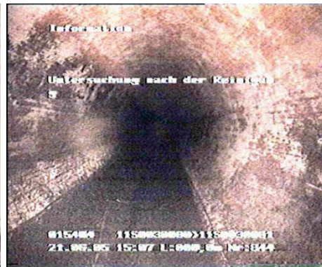
Abb. 71: Leitung nach der Reinigung
