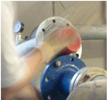
Abb. 52: Einbringen des Molches in die Druckleitung
