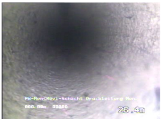
Abb. 107: Bildausschnitt – Inspektion gegen die Fließrichtung vor Zugabe von „Lipolyt 2000“
