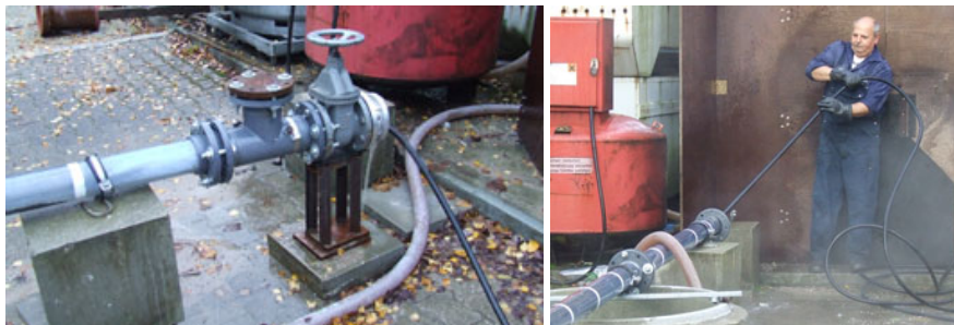
Abb. 164: Über geöffnetes Leitungsende eingebrachter Spülschlauch (li) und Ziehen des Spülschlauches (re)
