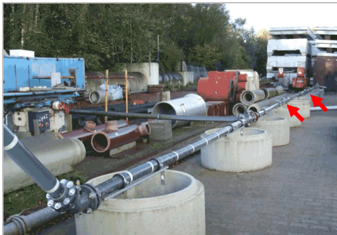
Abb. 143: Bereich der eingebrachten Ablagerungen Fett, Fett/Sand, Flüssigboden, Estrich (s. Pfeile)
