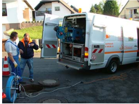
Abb. 29: Inspektionsschacht ca. 150 m hinter der Pumpstation
