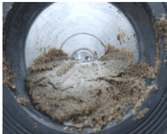
Abb. 133: Beispiel für eingebrachte Ablagerung eines Fett-Sand-Gemisches
