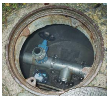
Abb. 36: Spül- und Entleerungsschacht
