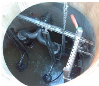
Abb. 86: Pumpenschacht Station 1 Abb. 87: Pumpenschächte Station 2 Abb. 88: Steuerung Pumpstation 2
