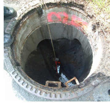
Abb. 65: H 2 S-Messung mit Gaswarngerät an der Schachtschle
