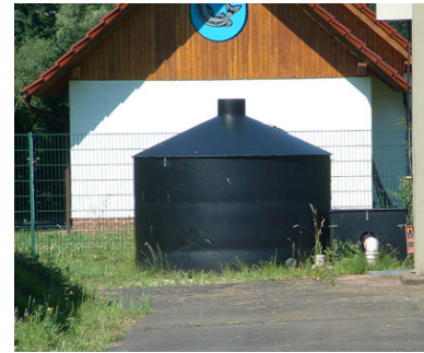
Abb. 7: Biofilter am Auslauf der Druckleitung
