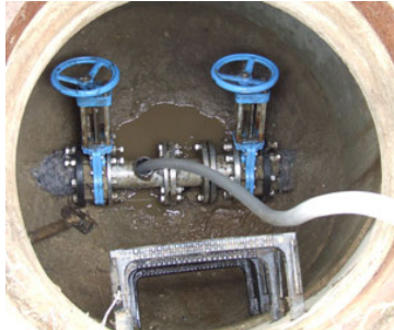
Abb. 103: Saugschlauch über Spülstutzen eingesetzt
