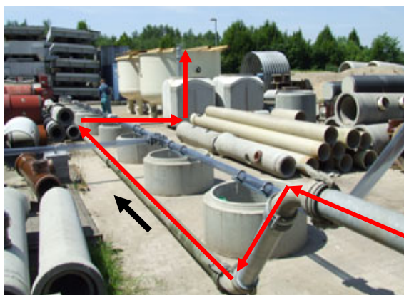
Abb. 129: Teil der Rückführung (s. Pfeile) und Wasserbehälter
