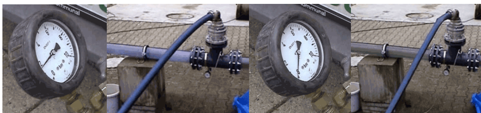
Abb. 141: Druckschlauch und Manometer unter Luftzugabe (li) und druckfrei (re)
