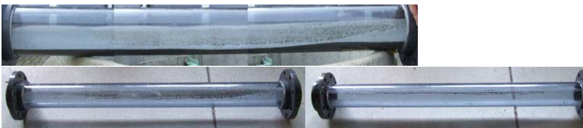
Abb. 145: Außenansicht des Estrich-Ablagerungen vor (oben) und nach (unten) der Reinigung
