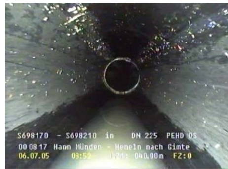
Abb. 21: Beispiel 3 – Inspektion nach der Reinigung
