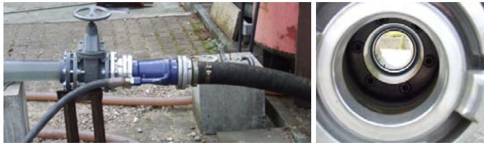
Abb. 174: Eingebauter Ejektor (C 16) (li) und Innenansicht des Ejektors (re)
