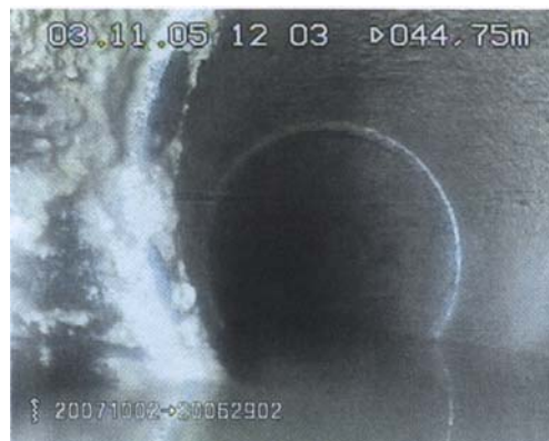
Abb. 84: TV-Inspektion vor der Reinigung, Bildausschnitt 2
