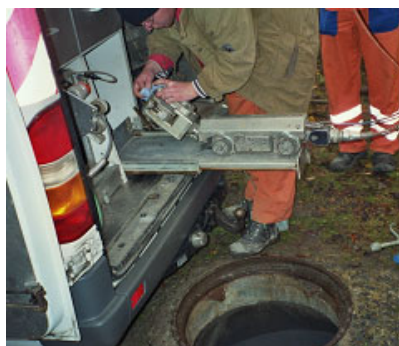
Abb. 44: Inspektionskamera
