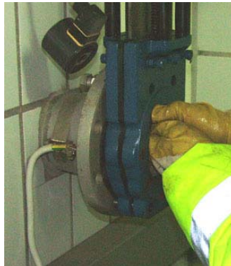
Abb. 78: Einschieben des Molches
