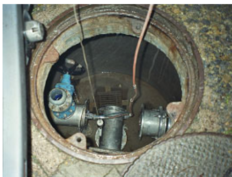
Abb. 43: Leitung mit demontiertem Pass-/Einbaustück
