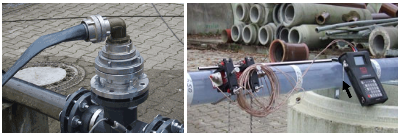
Abb. 139: Anschluss des Luftdruckschlauches (li); Durchflussmessgerät (re)
