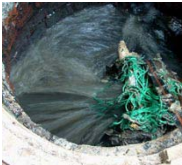
Abb. 60: Auslauf während des ersten Spüldurchgangs
