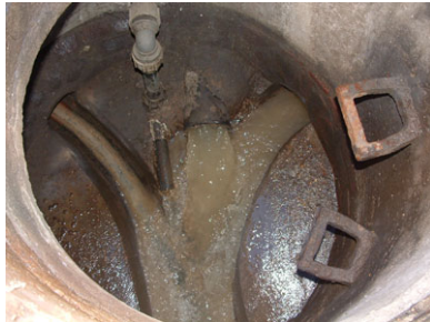
Abb. 89: Übergabeschacht „Hilfringhauser Straße“
