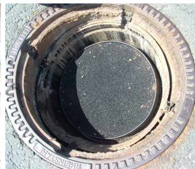
Abb. 51: Geruchsfilter am Freispiegelkanal
