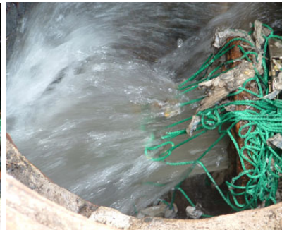
Abb. 61: Auslauf während des zweiten Spüldurchgangs
