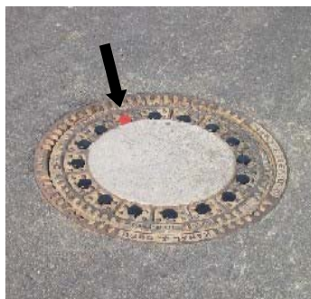
Bild 31: Pfropfen (schwarz) zum Verschluss der Schachtdeckung (MH-Vertrieb)
