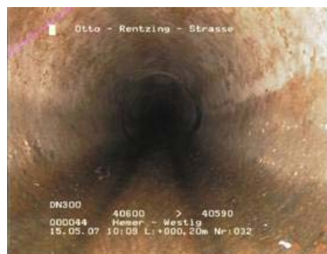
Bild 49: Untersuchter Abwasserkanal (STZ, DN 300, MW, 2-Jahre ohne Reinigung)
