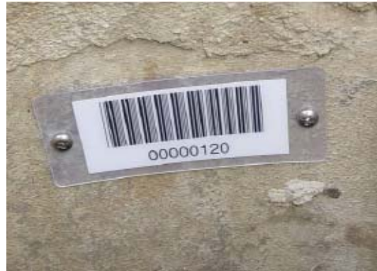
Bild 25: Barcode im Schacht (Ame- ris GmbH)
