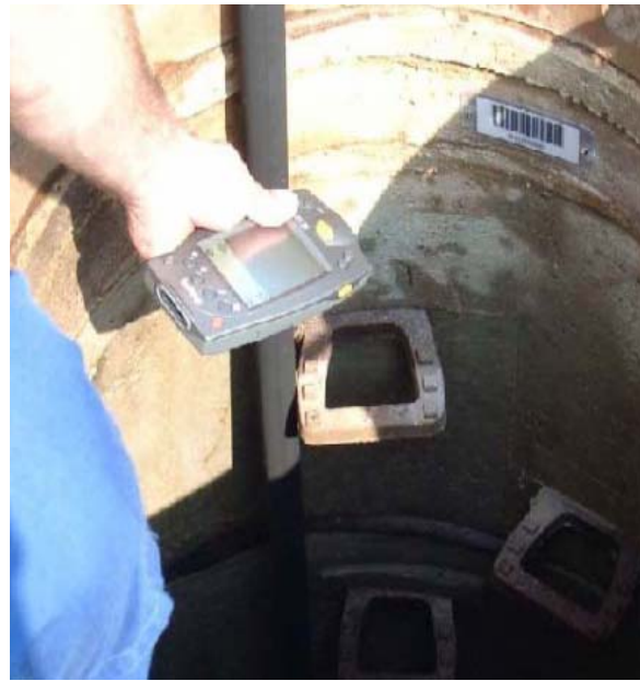
Bild 27: Einscannen des Barcodes im Schacht
