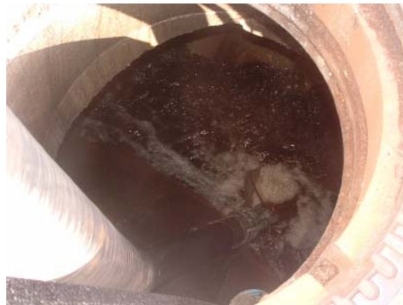
Bild 75: Aufsaugen von Ablagerungen mit dem Saugschlauch
