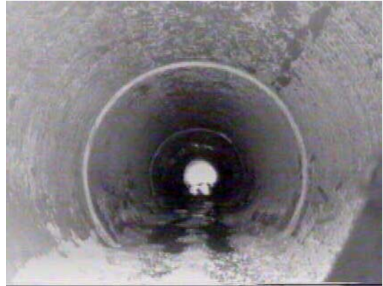
Bild 7: Ablagerungssituation aus Sicht der „Sehenden Düse“
