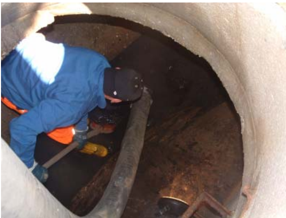
Bild 74: Schachteinstieg und manuelles Schaufeln von Ablagerungen
