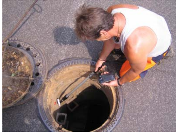
Bild 87: Einlesen der Schachtnummer in ein Handheldgerät mittels Transponder, Beispiel
