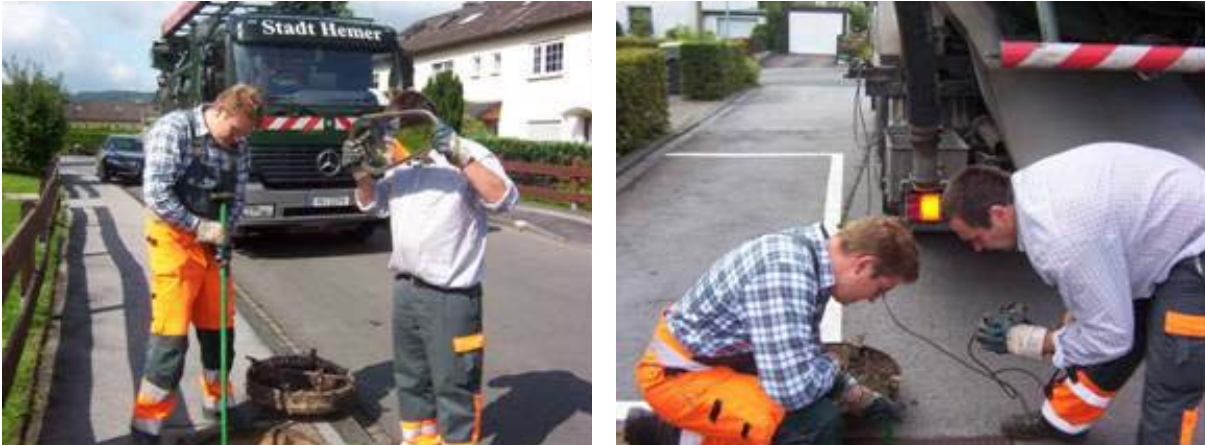
Bild 46: Einsatz des Kanalspiegels in Hemer, links: Ausnutzung des Sonnenlichtes, rechts: Verwendung einer externen Lichtquelle
