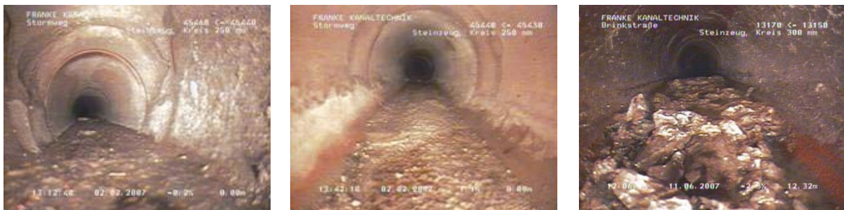
Bild 57: Beispiele für Abwasserkanäle in unmittelbarer Nähe von Baumaßnahmen
