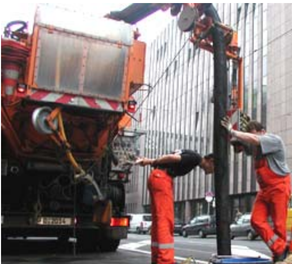
Bild 4: Beobachten der Hochdruckreinigung im Schacht
