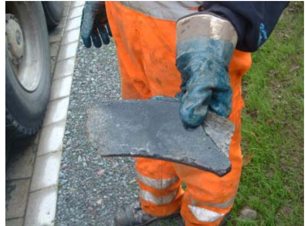
Bild 71: Asphaltmaterial als entnommenes Kanalräumgut
