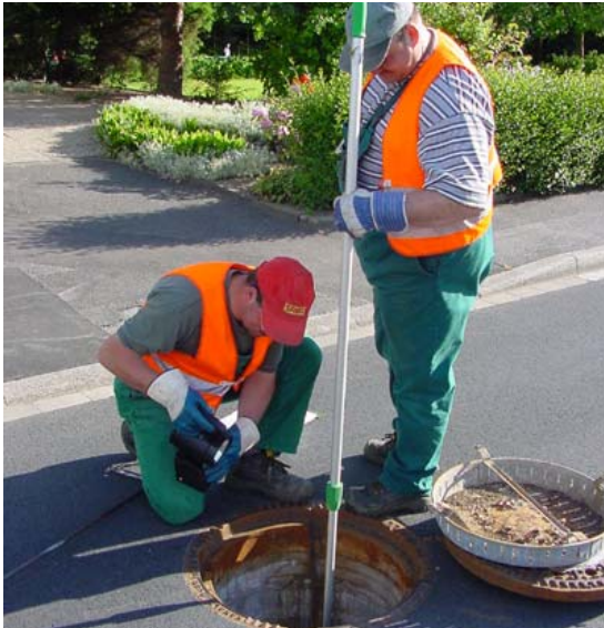
Bild 1: Bildbeispiele zu einer Kanalspiegelung
