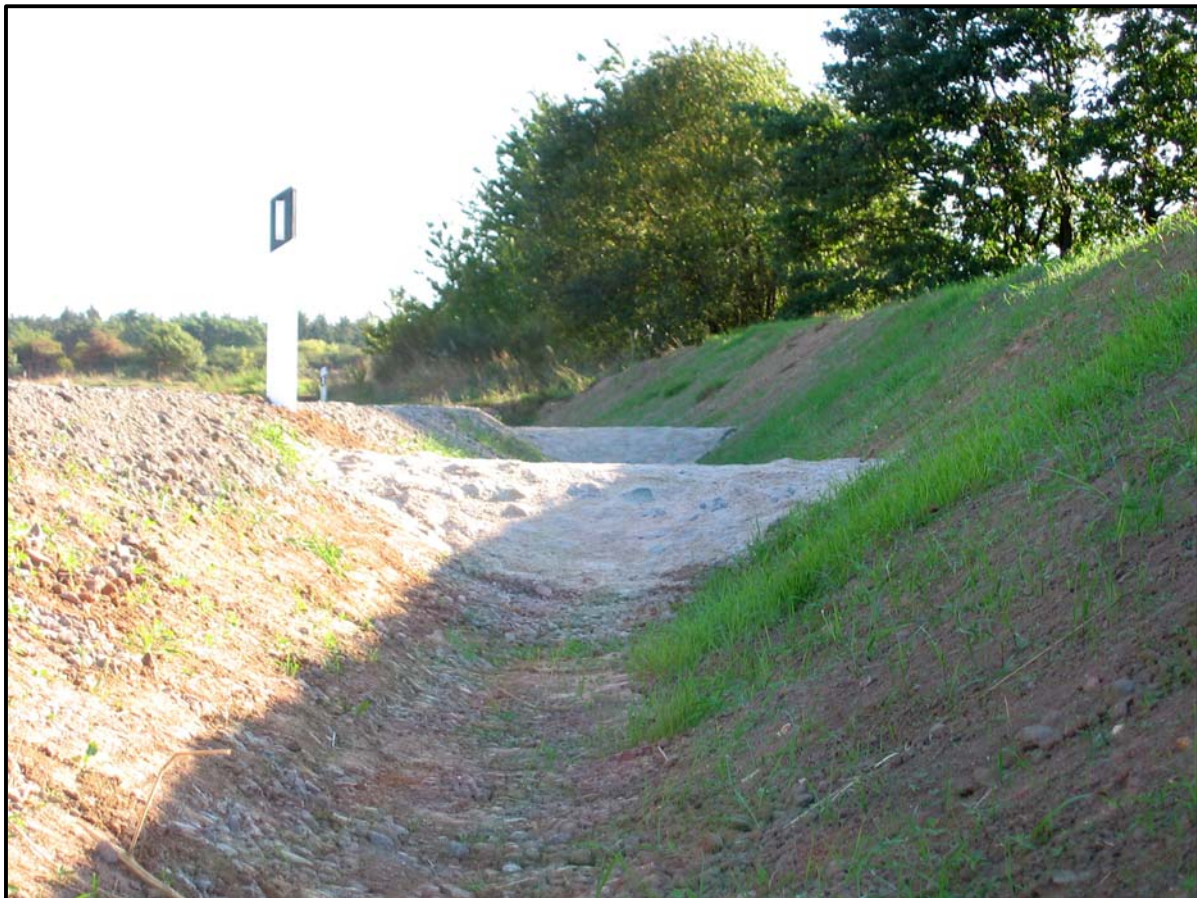
Bild 4.5: Versickerungsgraben mit befestigten Querriegeln (VA2), Vegetationsdecke noch nicht geschlossen (Blick in Längsrichtung); bei derartigen befestigten Querriegeln sind Schutzplanken anzuordnen
