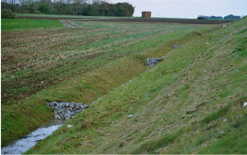
Bild 1: Ansicht Versickerungsgraben am Böschungsfuss; rechts Böschung der A 4
