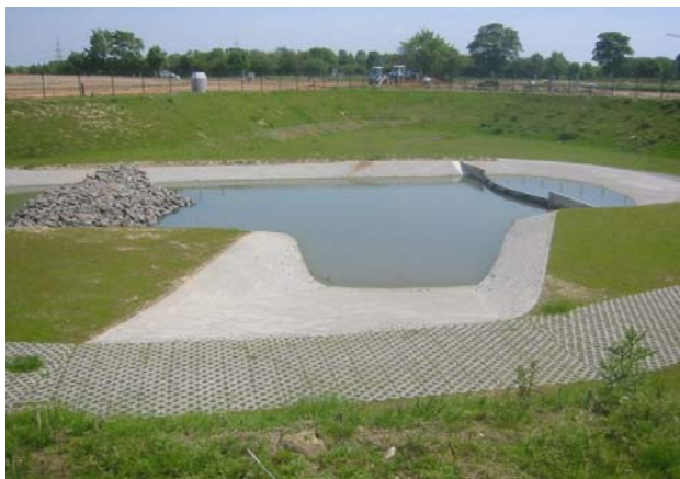
Bild 3: Unterhaltungsweg aus Rasengittersteinen und gepflasterte Zufahrtsrampe zum Absetzbecken
