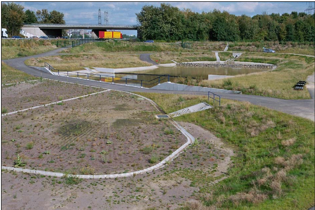
Bild 4.9: Versickerungsbecken (Vordergrund, Vegetationsdecke ist noch nicht voll ausgeprägt) mit Absetzbecken und zugehörigem Leichtstoffabscheider (Hintergrund) (VA4)
