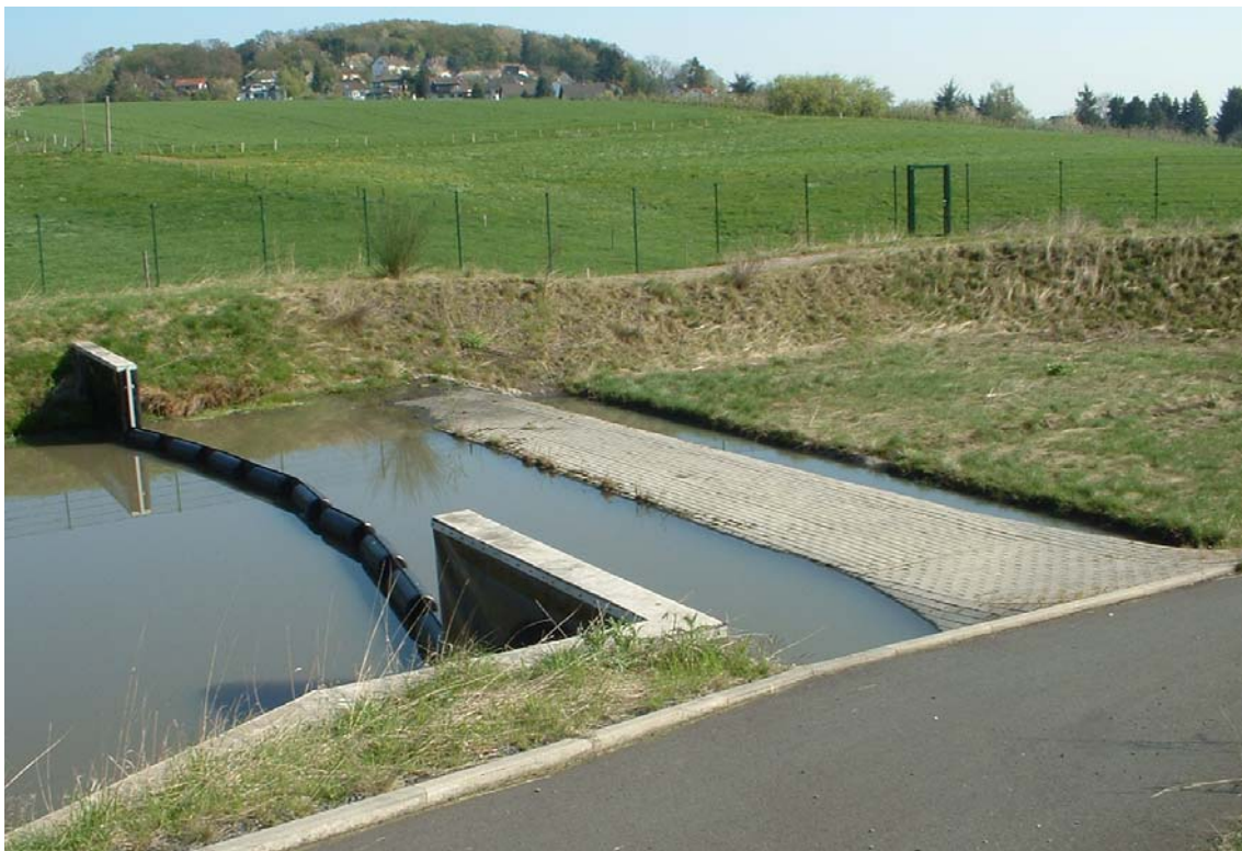
Bild 4.25: Bodenfilterfläche, Blick über die Vorstufe mit schwimmender Tauchwand auf die Filterfläche
