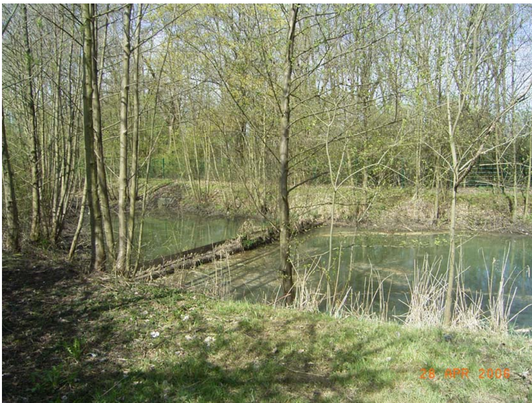
Bild 4.21: Regenklärbecken mit Dauerstau in Erdbauweise
