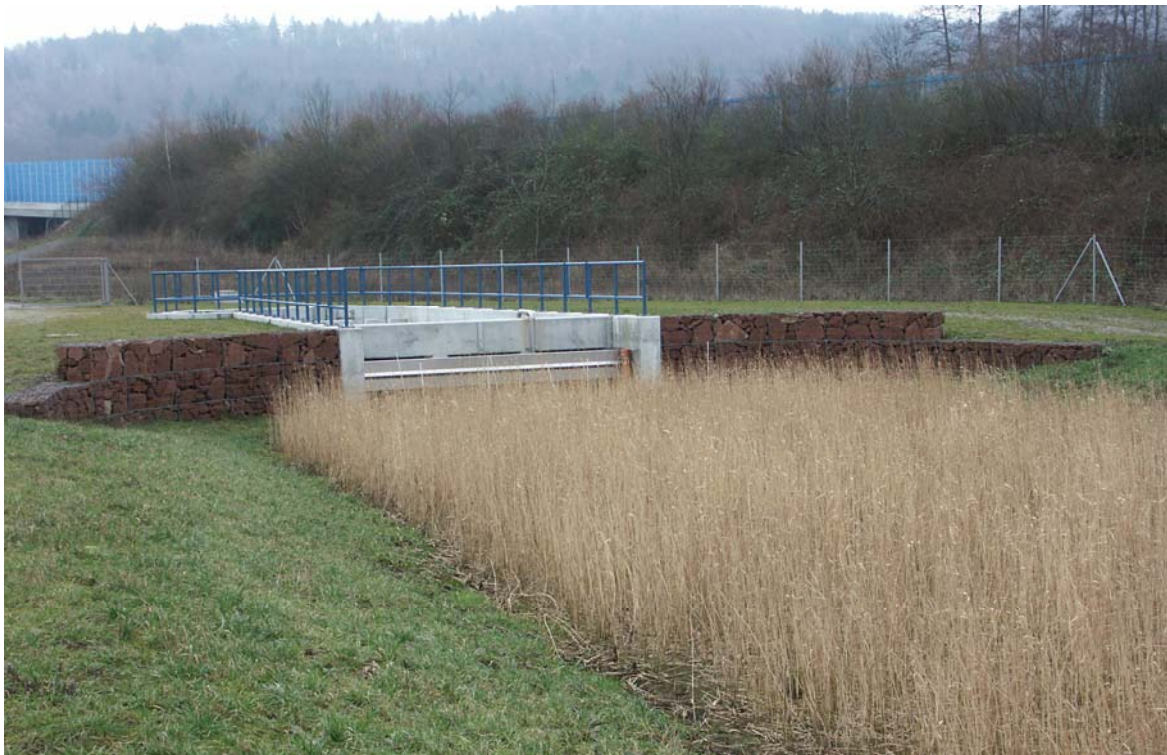
Bild 4.23: Retentionsbodenfilteranlage, Blick über den Filter in Richtung Vorstufe (ROTH 2005)
