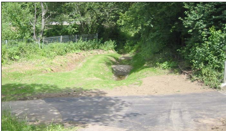
Bild 3: Versickerungsgraben mit Querriegeln, Blick in Längsrichtung
