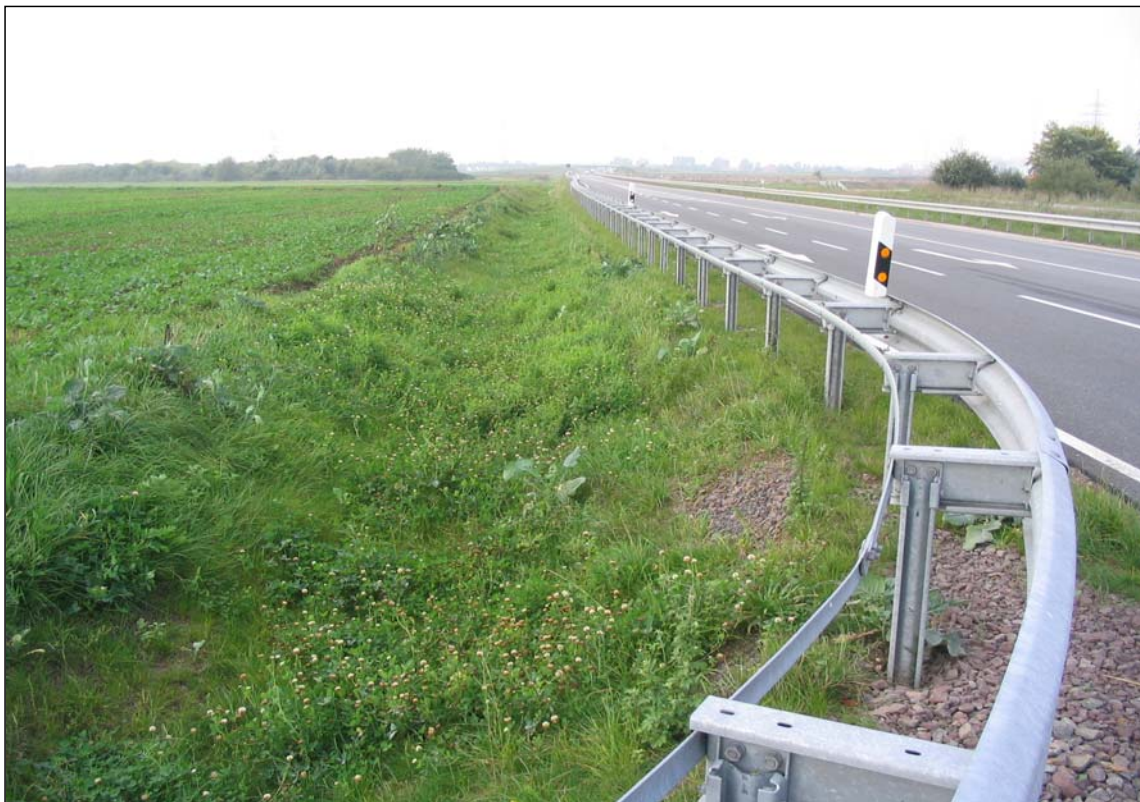
Bild 2: Versickerungsgraben, Neubau L770, Bauabschnitt 6, Landesbetrieb Straßen NRW, Oktober 2005
