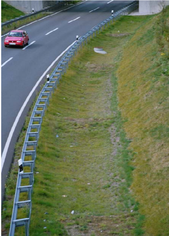
Bild 1: Versickerungsmulden im Einschnittsbereich mit Schwellen
