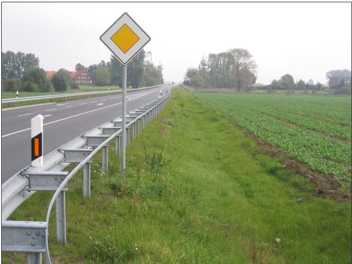
Bild 4.2: Großflächige Versickerung über die Böschung (VA1)
