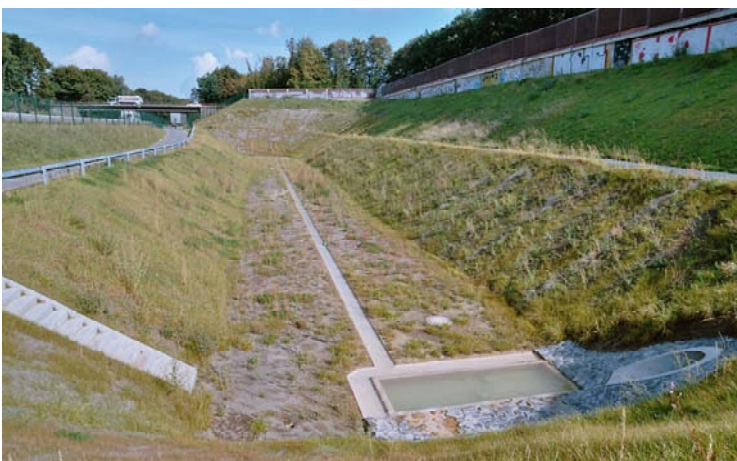
Bild 3: Versickerungsbecken unterhalb von Bodenfilterbecken; Einmündungsbereich im Vordergrund mit Absetzbecken; Verteilungsrinne in Beckensohle
