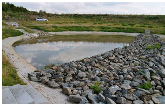
Bild 3: Tosbeckenbereich Vordergrund: Trennung von Tos- und Absetzbereich als Steinschüttung mit vorbereiteter Pflanzmulde
