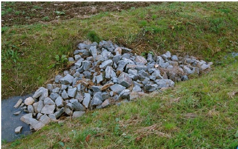
Bild 2: Detail Querriegel aus Wasserbausteine
