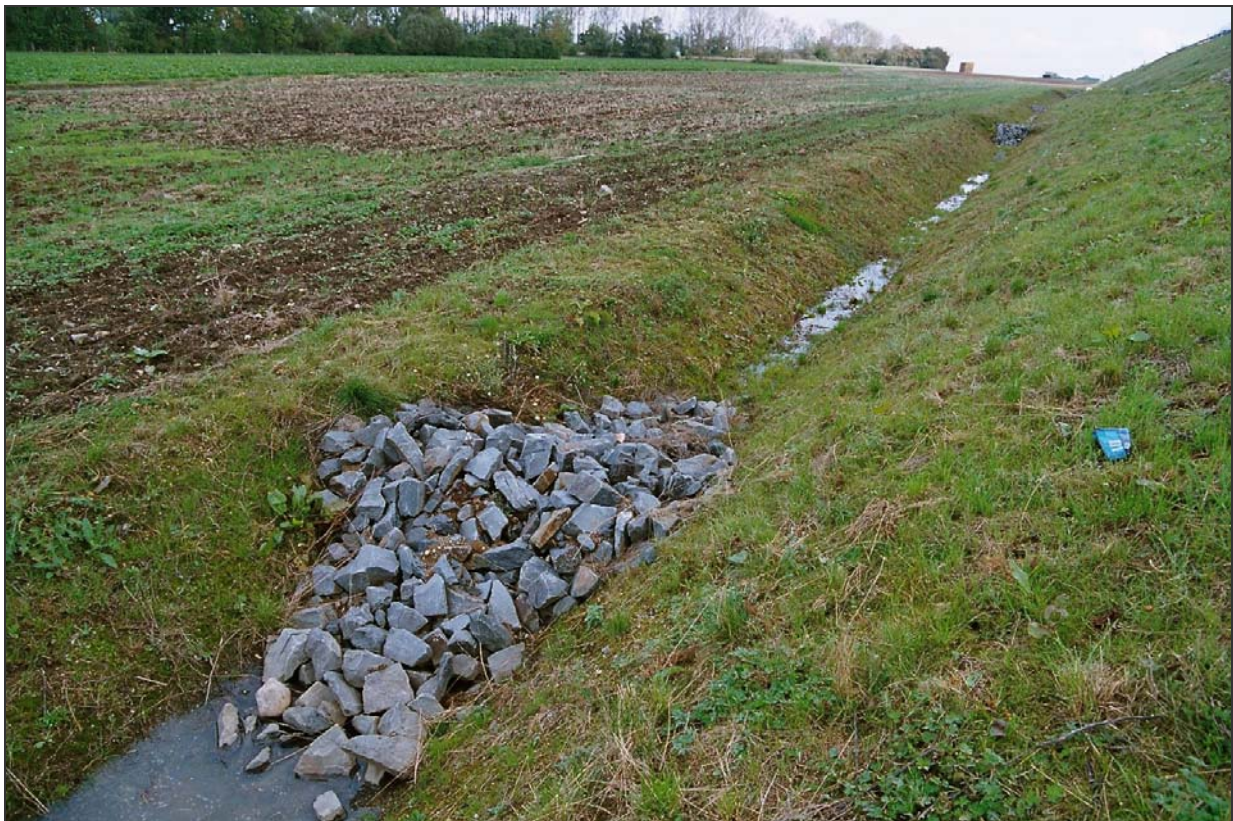
Bild 4.12: Straßenseitengraben mit durchlässigen Querriegeln am Böschungsfuß einer Autobahn (rechte Bildseite) (A1)
