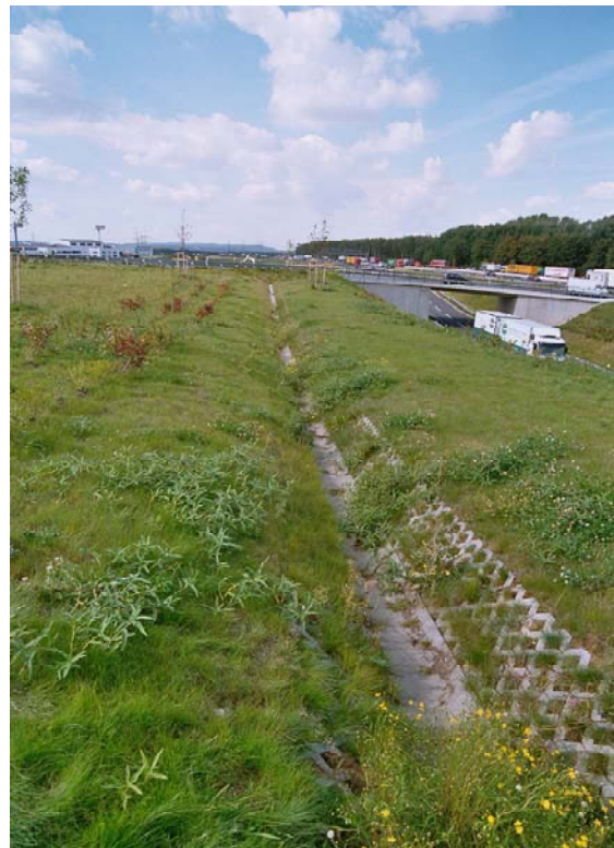
Bild 2: Abfanggraben oberhalb der Böschung / des Einschnittes
