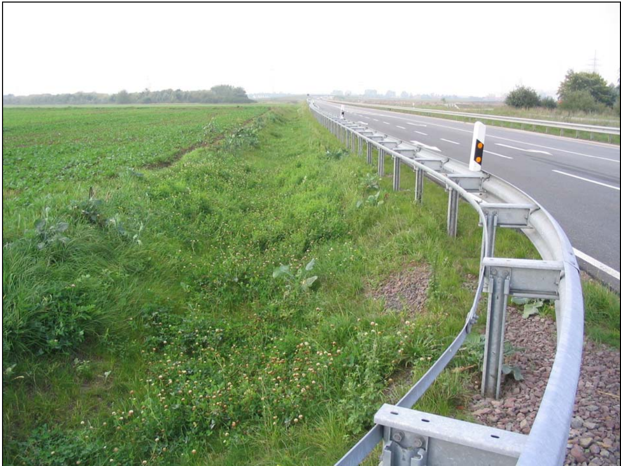
Bild 4.7: Mulden-Rigolen-Element als Linienelement im Straßenseitenraum (VA3)
