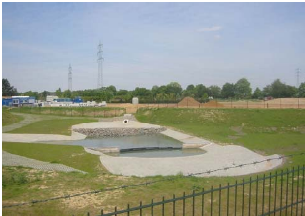
Bild 2: Absetzbecken mit beweglicher Tauchwand (Bildmitte) und Versickerbecken (rechter Bildrand)
