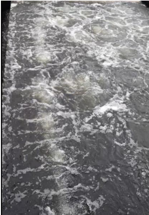
Abbildung 33: Wasserspülung ausgelöst nach Höhenstand
