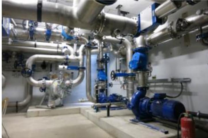
**Abbildung 10: Mazerator mit Transfer- und Umwälzpumpe**
