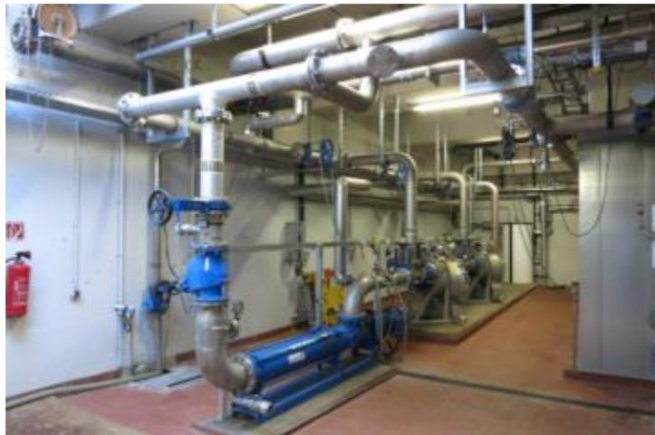
**Abbildung 11: Co-Substratannahme mit Steinfang, Mazeratoren und Pumpe**
