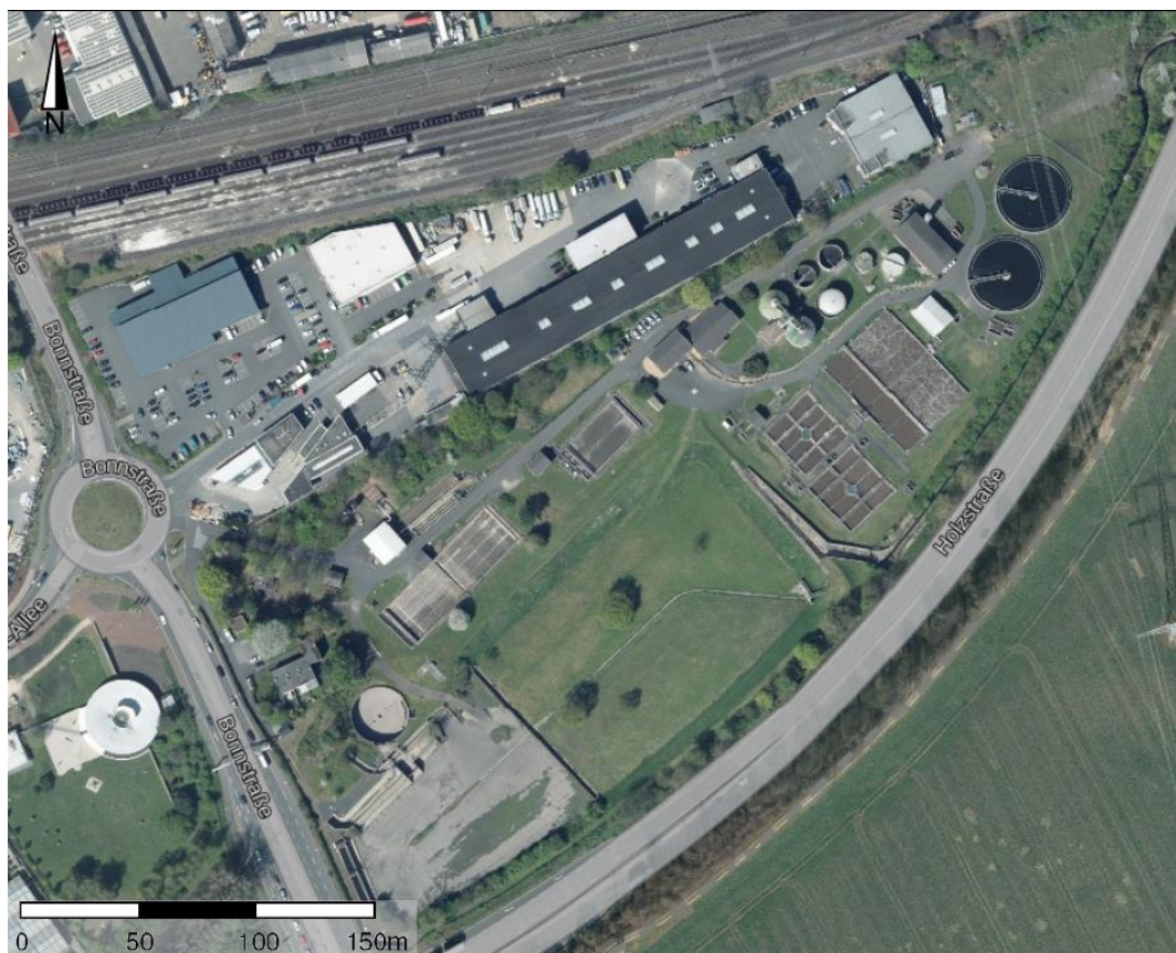
Abbildung 1: Luftbild des Betriebsgeländes der KA Frechen
