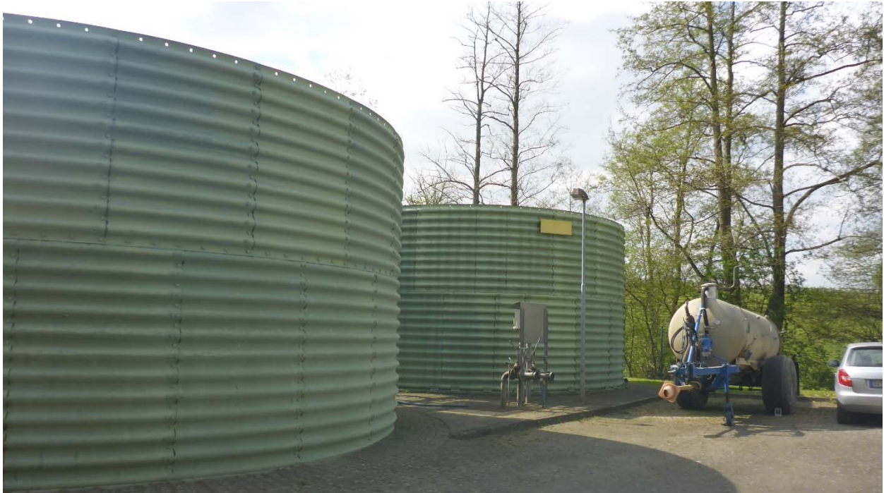
Abb. 6-3: Schlammstapelbehälter
