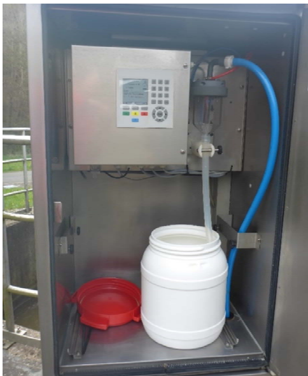
Abb. 6-8: Innenansicht stationärer Probenehmer
