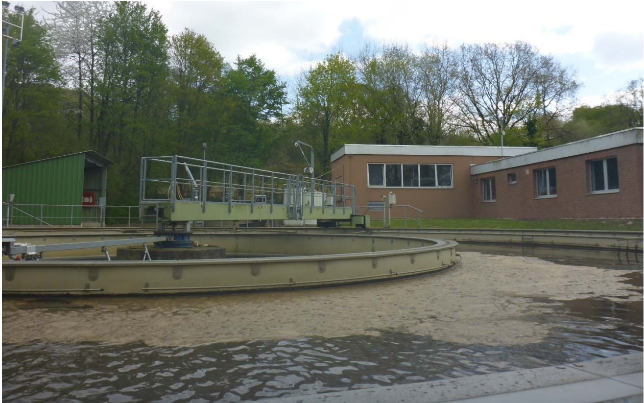
Abb. 6-2: Kombinationsbecken
