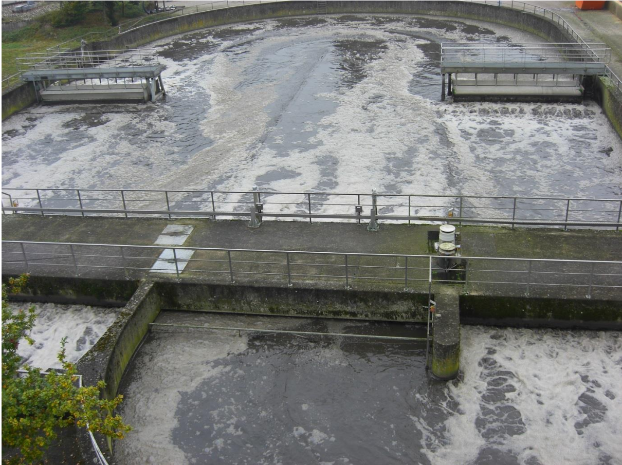
Abbildung 11: Ehemaliges Belebungsbecken I (Quelle: Ruhrverband)
