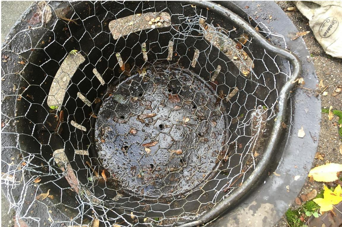
Abbildung 17: Mit Sechseckdraht ausgekleideter Laubfang
