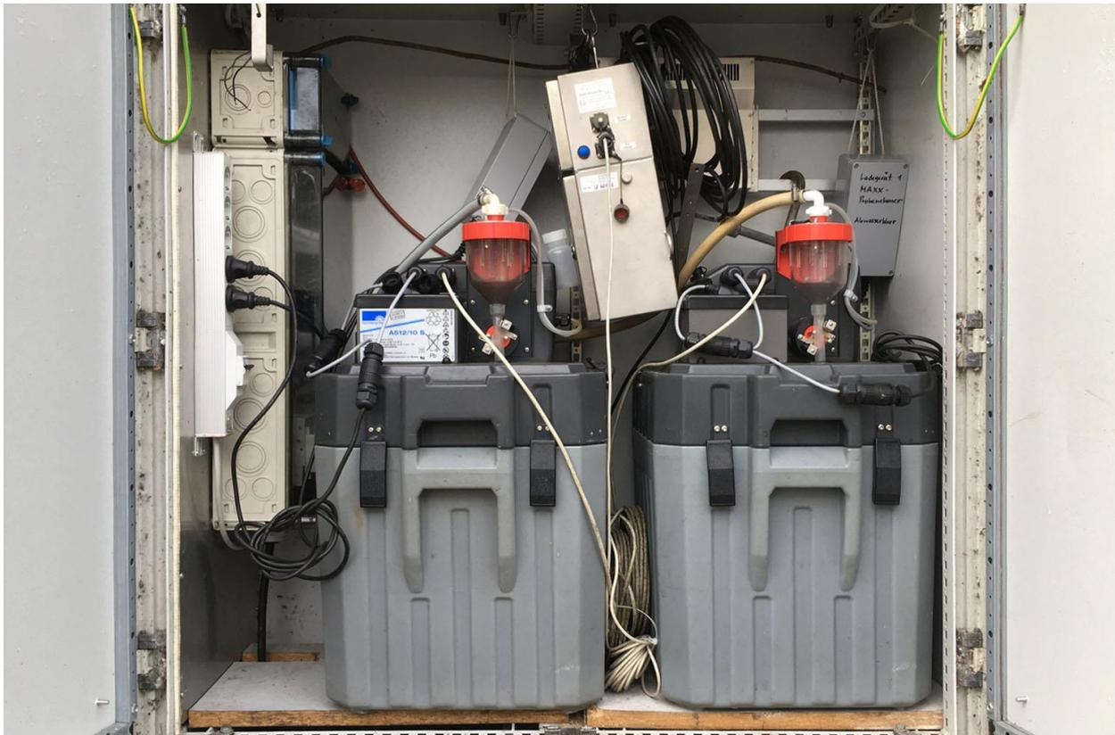
Abbildung 5: Blick in den Schaltschrank mit den beiden Probenehmern und dem Q-Logger (Mitte)
