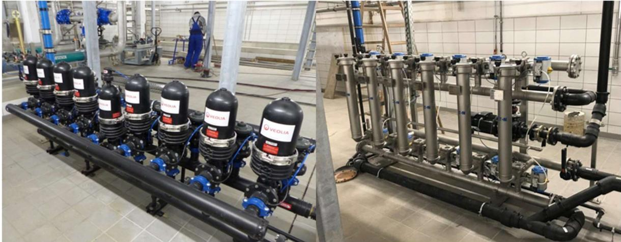
**Abbildung 3-4** Scheibenfilter BERKAL™ (links), Beutelfilter (rechts)
