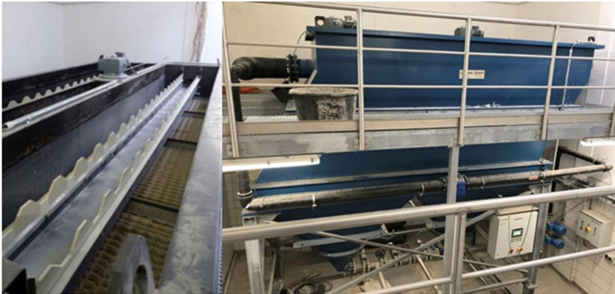
Abbildung 3-1 Lamellen des Schrägklärers (links), Schrägklärer (rechts)
