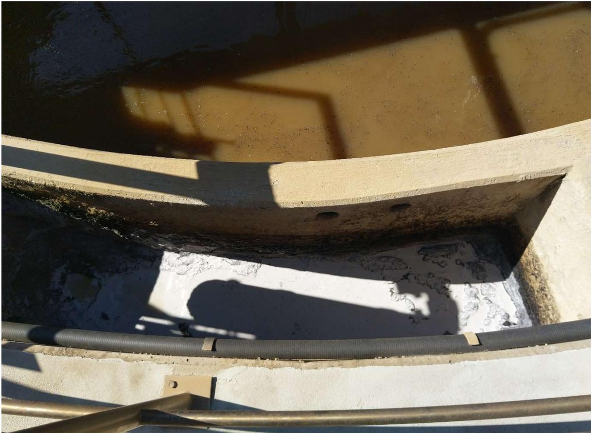
**Abbildung 4-26 Kalkablagerung im Schlammabzugs-Sumpf des Zentratwasserspeichers während des Kalkmilch-Versuchs**
