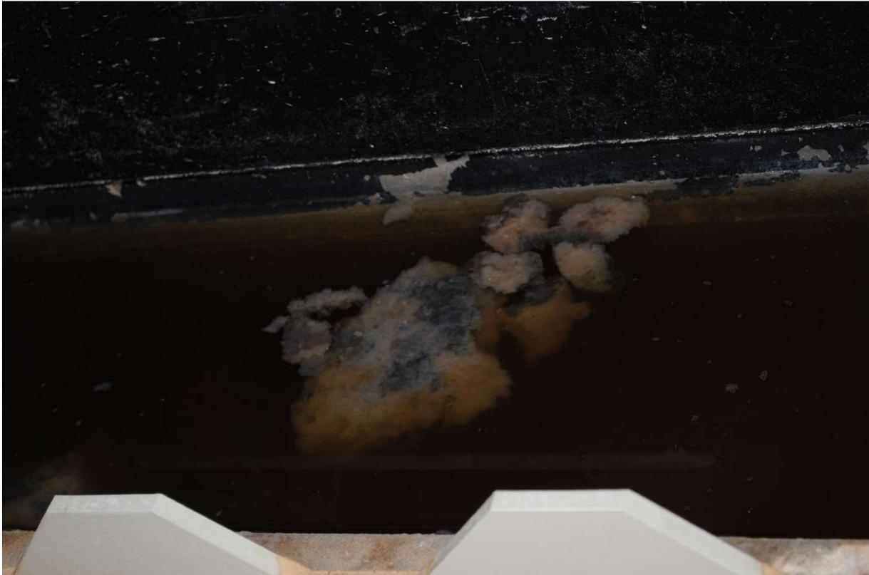
**Abbildung 4-6 Agglomerate im Ablauf des Schrägklärers bei der Inbetriebnahme 2018**
