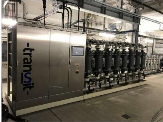
Straßen mit je drei Stufen aufgebaut: die erste Stufe besteht aus je zwei Membrankontaktoren, die zweite und dritte Stufe bestehen aus je drei Membrankontaktoren. Das Prozesswasser im Ablauf der Membrankontaktorenanlage wird dem Einlaufbauwerk der Hauptkläranlage zugeführt. Ein grundsätzliches Verfahrensschema der Prozesswasserbehandlungsanlage ist in Abbildung 3-7 dargestellt.
