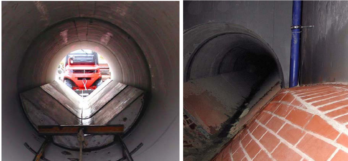
Bild 3-29: Rinnenwärmetauscherelemente der Firma Rabtherm GmbH vor und nach dem Einbau
