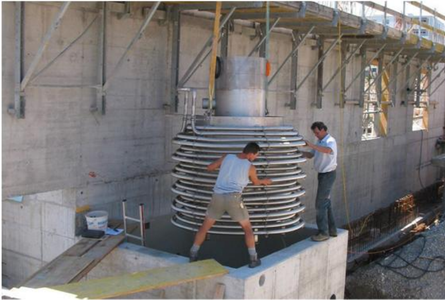
Bild 3-9: Einbau FEKA-Modul in den Abwasserschacht einer Wohnüberbauung (FEKA-Energiesysteme AG 2010)
