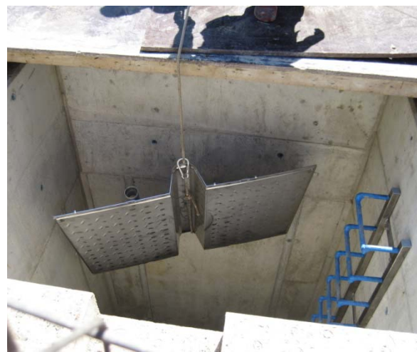
Bild 3-31: Wärmetauschereinbau im Marbachkanal in Bochum
