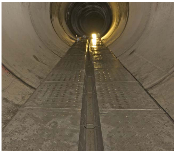
Bild 3-31: Wärmetauschereinbau im Marbachkanal in Bochum
