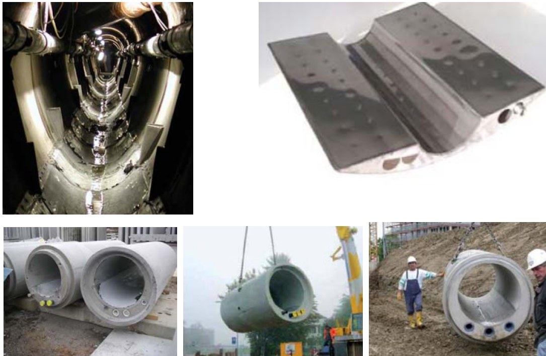
Bild 3-13: Oben: Beispiel eines nachträglich eingebauten Wärmetauschersystems für den Einbau in bestehende und in neue Kanäle
