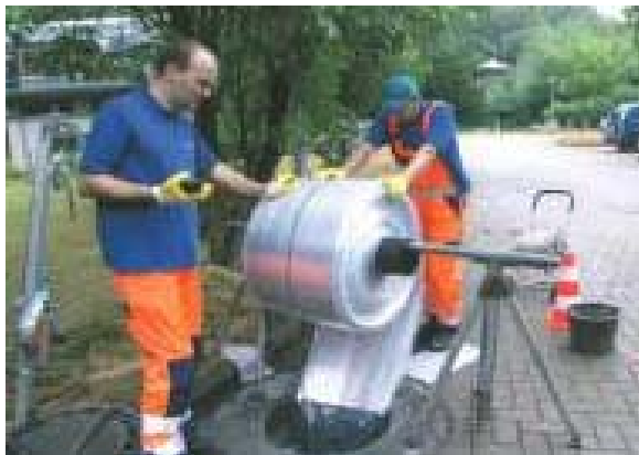
Bild 3-27: Rinnenwärmetauscher (Inlining) System Brandenburger Heatliner
