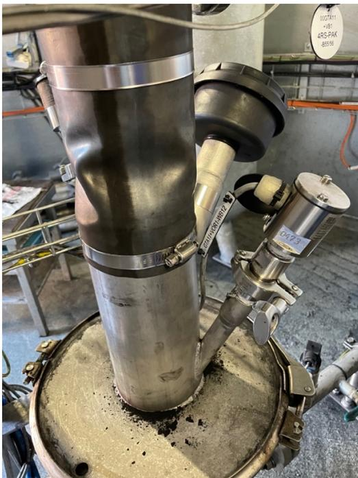
**Abb. 16:** PAK-Austritt an Einmischanlage
