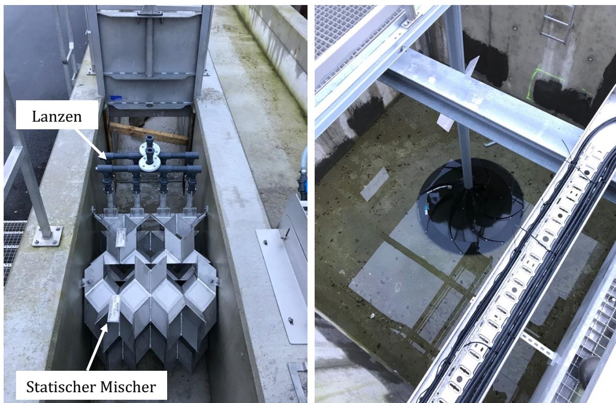
**Abb. 4:** Einmischung PAK in Zulaufstrecke **Abb. 5:** Hyperboloid-Rührwerk
