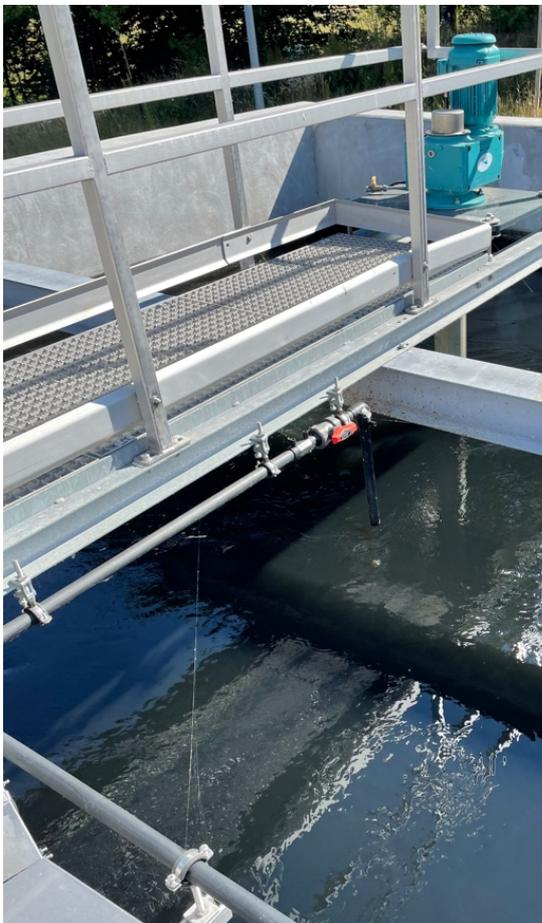
**Abb. 22:** Dosierung Rohröffnung
