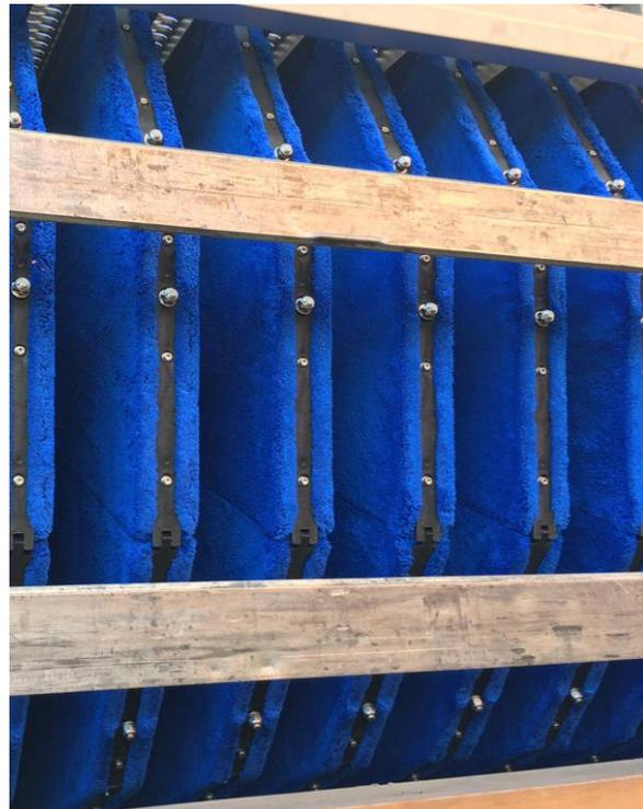
**Abb. 7:** Tuchfiltersegmente
