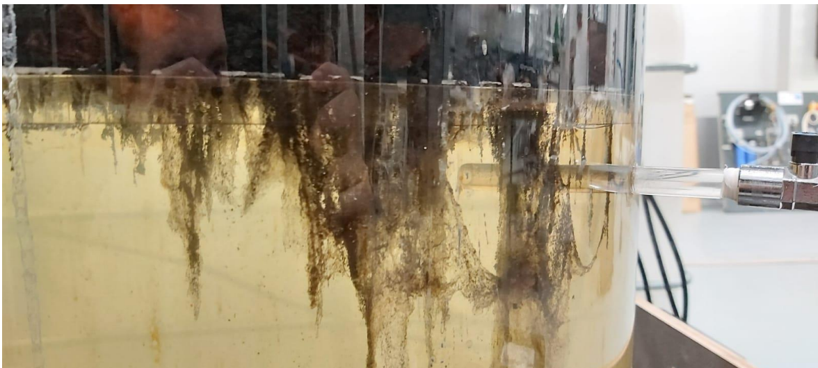
Abbildung 74: Algen oder Schimmelbildung unterhalb der Filterschüttung
