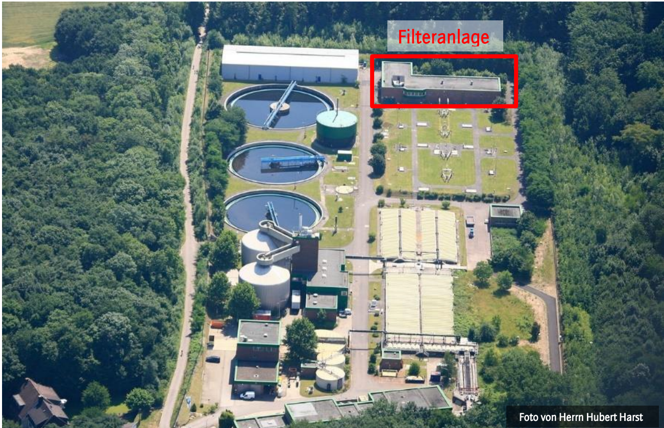
Bild 3: Luftbildaufnahme des Klärwerks Köln-Rodenkirchen
