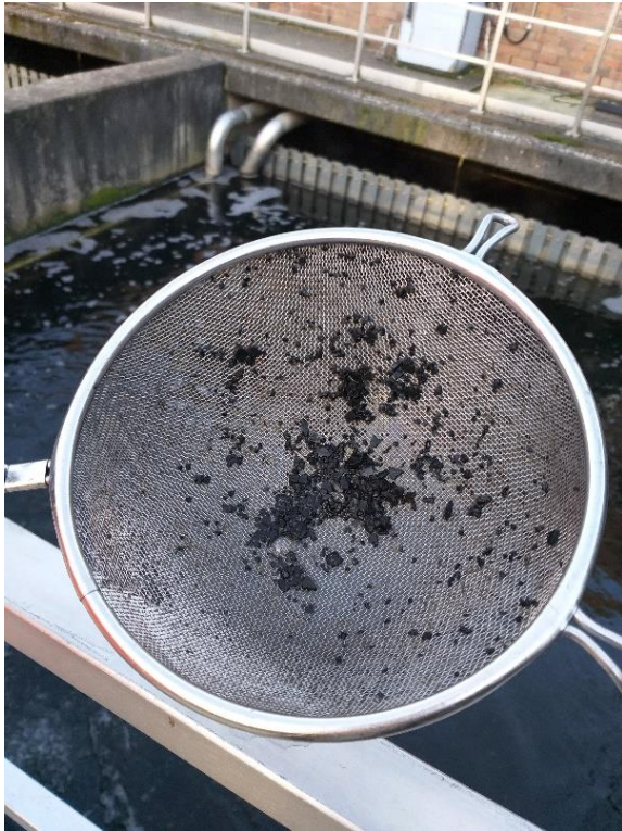
Bild 74: Sieb mit Aktivkohle vor Einbau der Entlüftungsleitung
