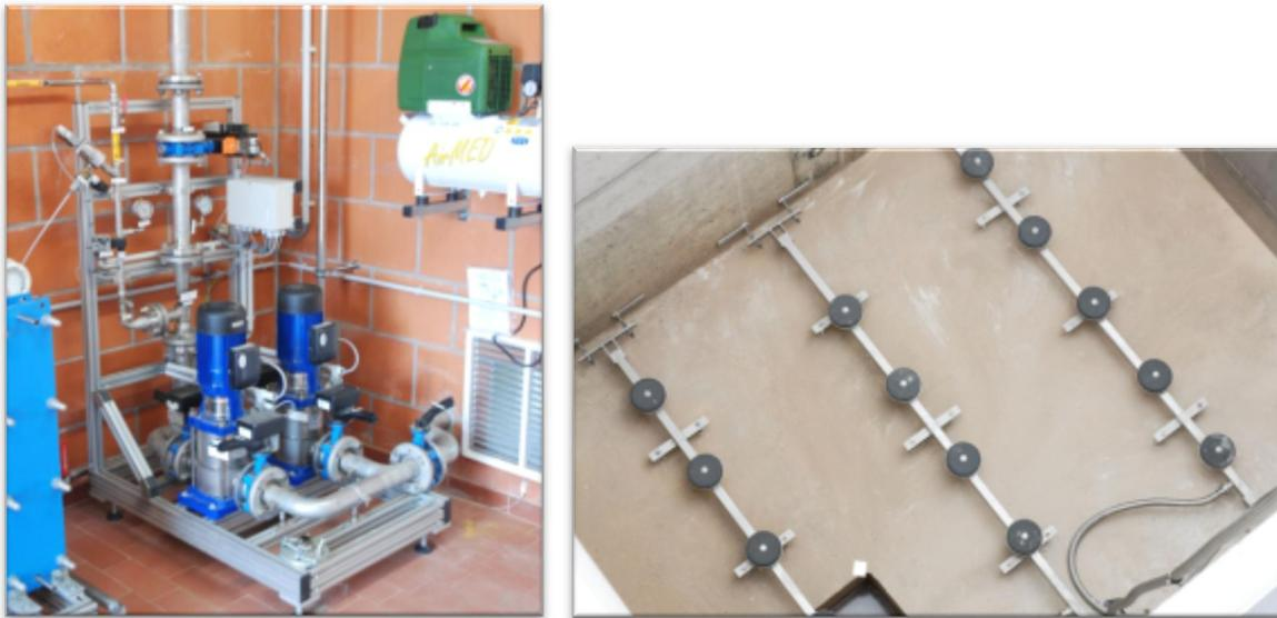
**Abbildung 5-3: Ozon-Eintragungssysteme, Injektor (links) und Diffusor (rechts)**
