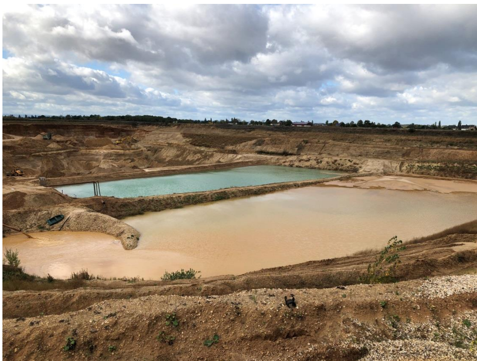
Abbildung A-10: Feldversuch in Vernich am 10.10.2019; Aufnahme der Absetzbecken während des zweiten Feldversuchs zum Versuchsende um 13:00 Uhr; Vorne im Bild ist das alte Absetzbecken; im Hintergrund das neue Absetzbecken
