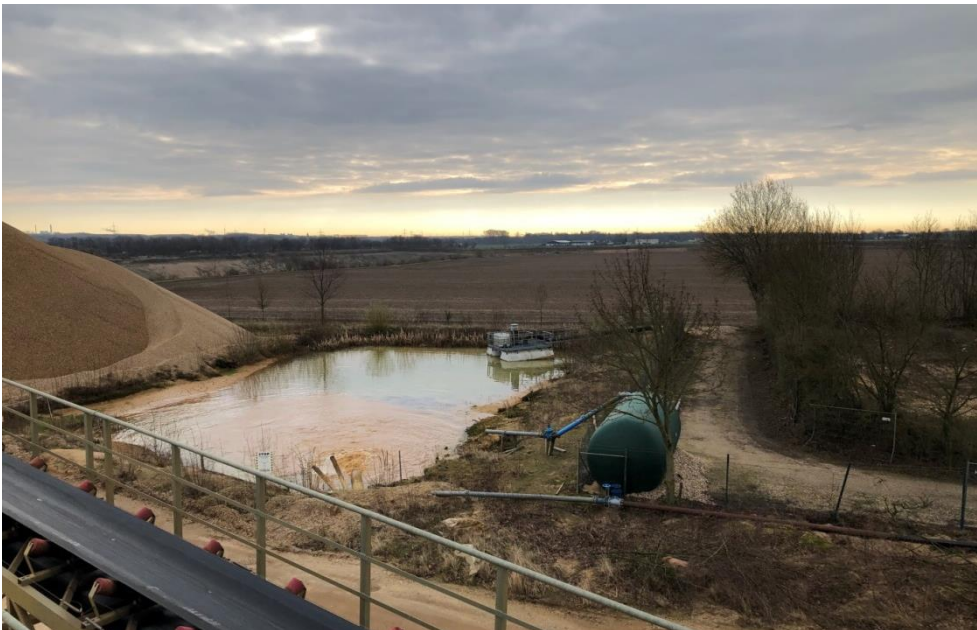
Abbildung A-5: Wasservorratsteich der Kieswäsche Gymnich
