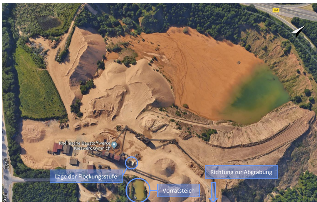
Abbildung 3-2: Satellitenbild der Kieswäsche Gymnich, ergänzt durch Anmerkungen; Hintergrundbild von GoogleMaps (GoogleMaps, 2019c)
