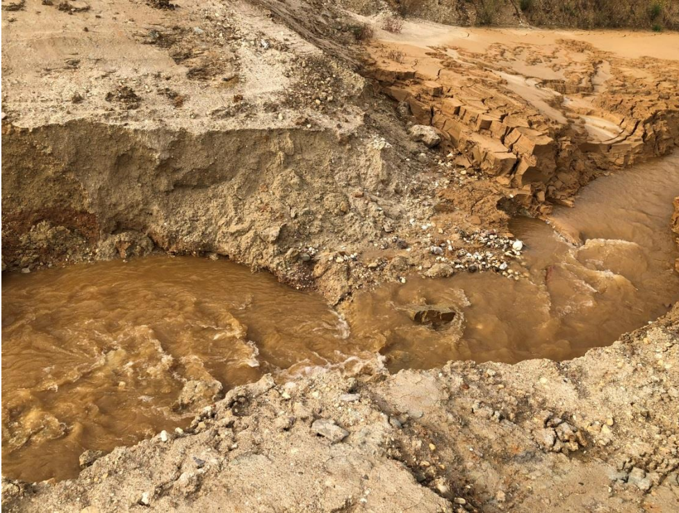
Abbildung A-8: Feldversuch in Vernich am 08.10.2019; Durchbruch im Damm zwischen den beiden Absetzbecken. Das Wasser fließt vom alten Absetzbecken (rechts) in das neue Absetzbecken
