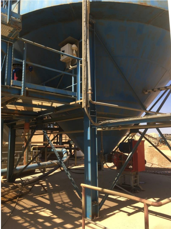
Abbildung A-1: Triplexklärer auf der Kieswäsche Gymnich
