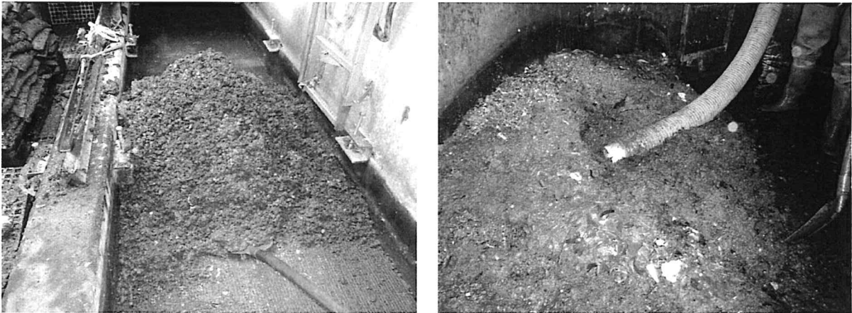
Bild 5: Ausbau des stark verunreinigten Filtermaterials und Entleerung des Sedimentationsraumes am 07.07.2015
