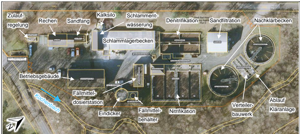
Abbildung 12: Luftbild der Kläranlage Aegidienberg mit Beschriftung des Anlagenbestands (Digitales Orthophoto nach ELWAS-WEB, 2020)
