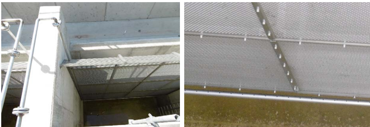
Abbildung 7: Mögliche Ausbildung des Siebblechs (links) und mögliche Ausbildung einer Siebbelüftung (rechts) (Quelle: Sweco).
