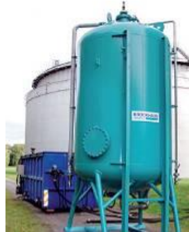
Bild 3.5: GAK als separater Druckfilter (Quelle: Herbst et al. 2013)
