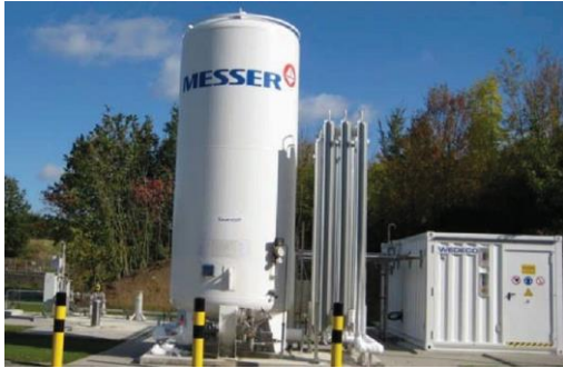
Bild 3.14: Sauerstofftank und Ozongenerator Bild 3.15: Ozon-Kontaktbecken (Lyko, 2013)
