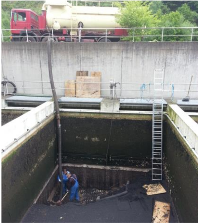
Bild 3.4: GAK als Ersatz für konv. Filtermaterial (Ausbau Anthrazit, Kolisch et al., 2014)
