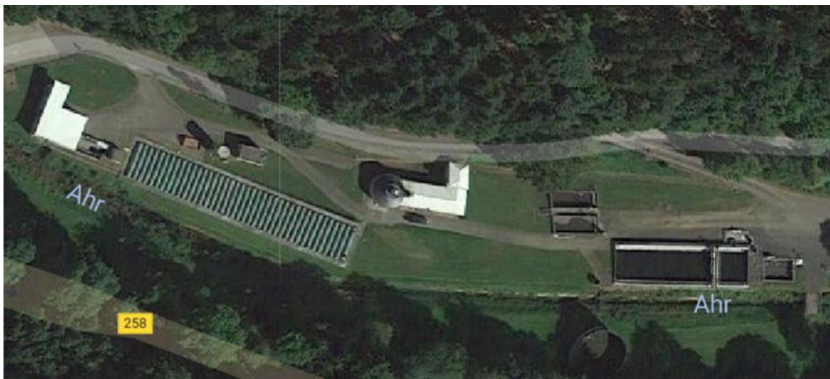
Bild 4.1: Luftbild der KA Blankenheim
