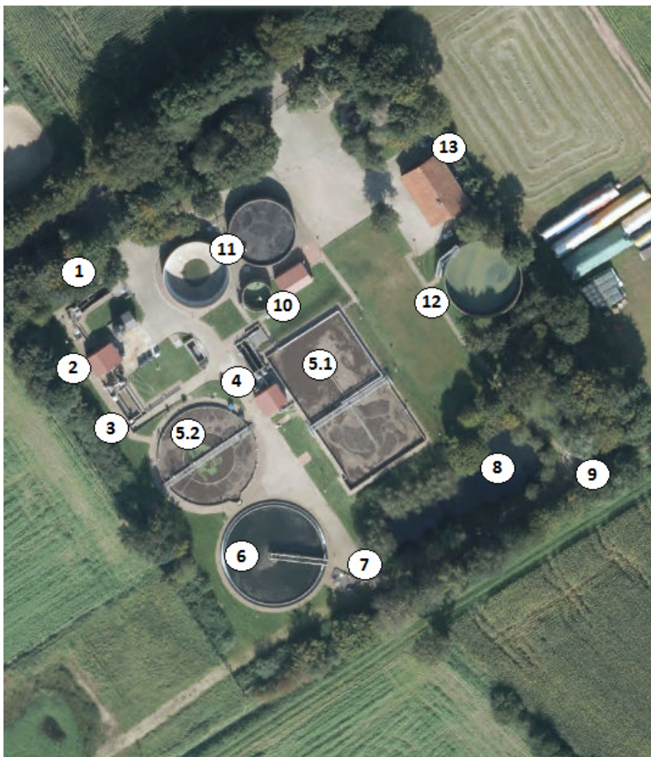
Abbildung 3.1: Luftbild der Kläranlage (verändert und ergänzt ELWAS-WEB, 2017)
