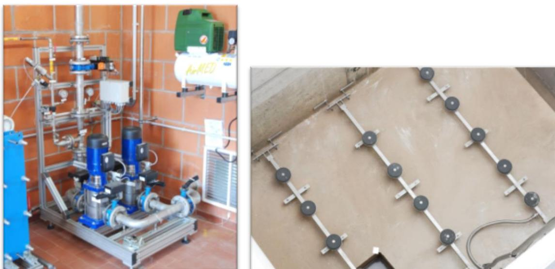
**Abbildung 5-3: Ozon-Eintragungssysteme, Injektor (links) und Diffusor (rechts)**
