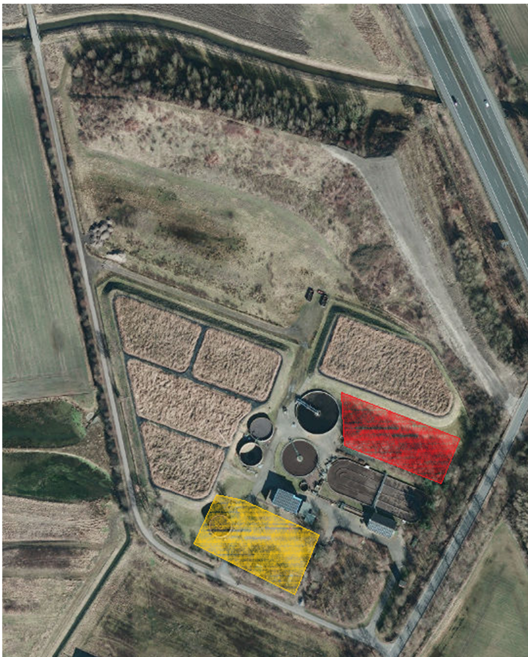
Abbildung 9.1: Ausgewählte Fläche für die 4. Reinigungsstufe auf der Kläranlage (verändert und ergänzt nach ELWAS-WEB, 2017)
