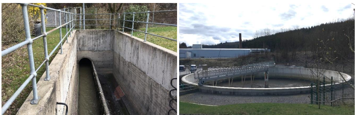
Abbildung 2.1: Trennbauwerk im Zulauf der Kläranlage und RÜB
