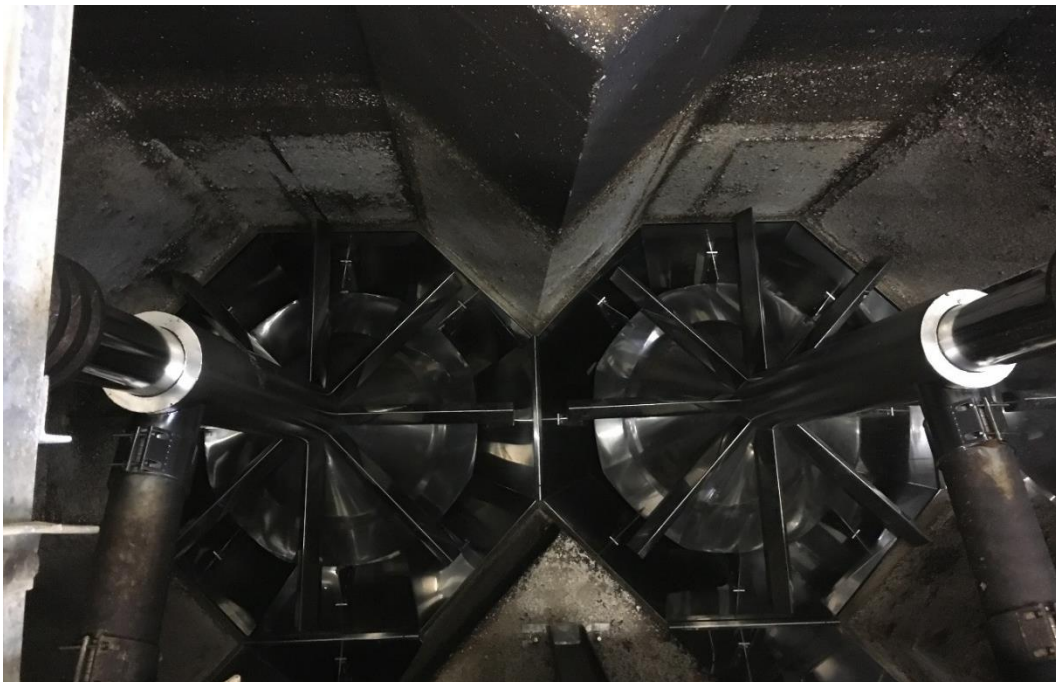
Abbildung 2.3: Entleerte DynaSand-Filter
