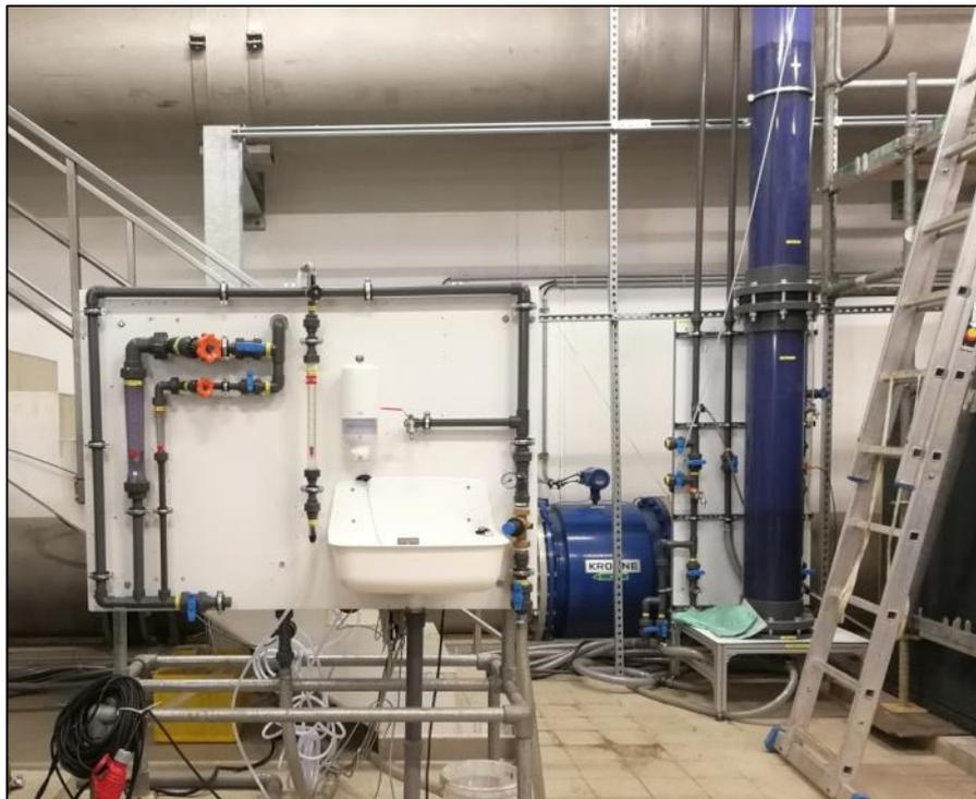
Abbildung 22: Mess- und Steuereinrichtung für die Filterspülung auf einer Schalttafel
