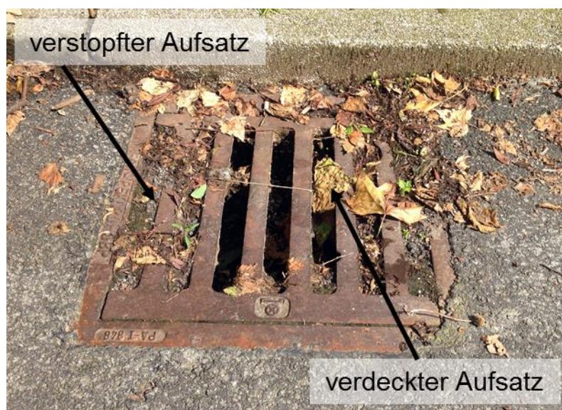
Abbildung 2: verstopfter und verdeckter Straßenablauf-Aufsatz
