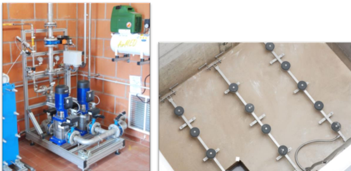
Abbildung 5-3: Ozon-Eintragungssysteme, Injektor (links) und Diffusor (rechts)
