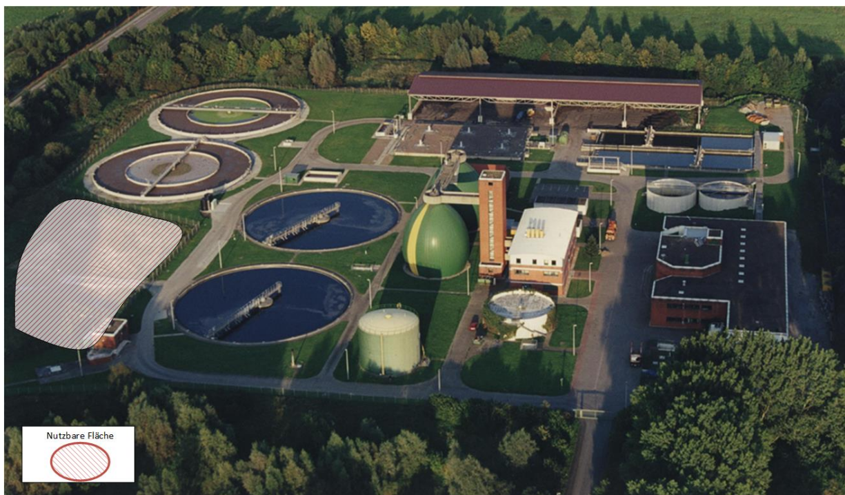
Abbildung 4-1: Potentielle Fläche zum Bau einer Stufe zur Mikroschadstoffelimination auf der Zentralkläranlage Lippstadt (Stadtentwässerung Lippstadt 2017)
