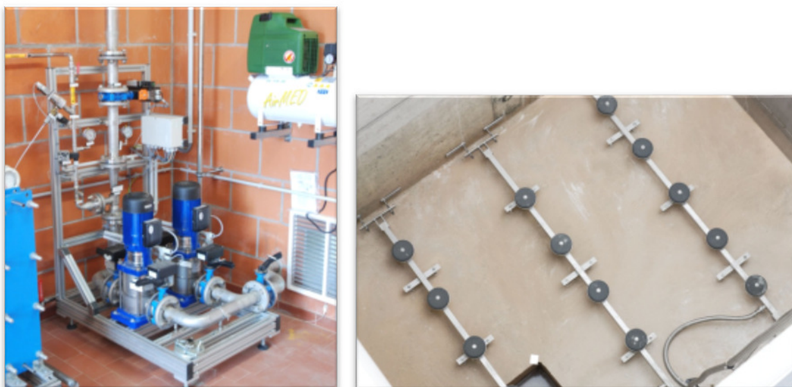
Abbildung 5-3: Ozon-Eintragungssysteme, Injektor (links) und Diffusor (rechts)
