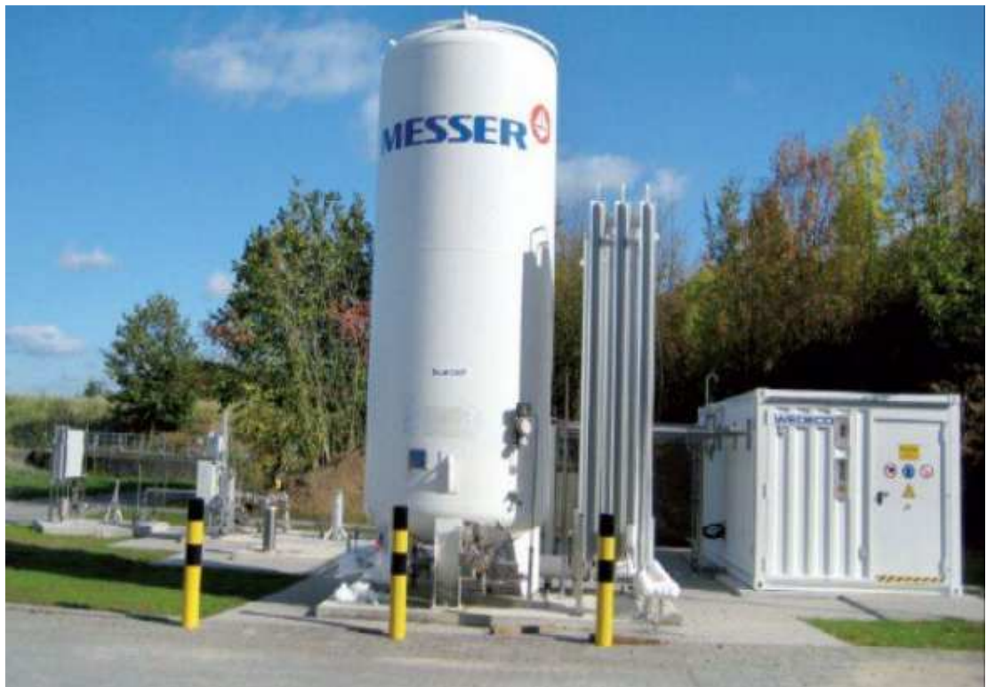
Abb. 5.1.1: Ozonanlage Bad Sassendorf in Containerbauweise ( Quelle: MKULNV, 2013)
