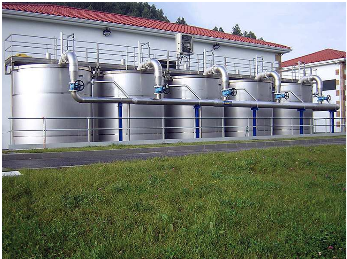
Abb.: 5.1.5: Filtrationsanlage CONTIFLOW® SS, Quelle Fa. HUBER SE
