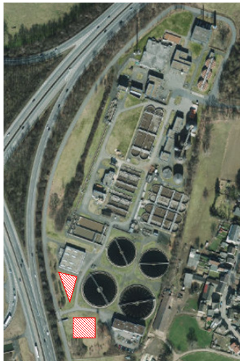
Abbildung 4-1: Potentielle Flächen zum Bau einer Stufe zur Mikroschadstoffelimination auf der ZABA Sankt Augustin (ELWAS-WEB, 2016)
