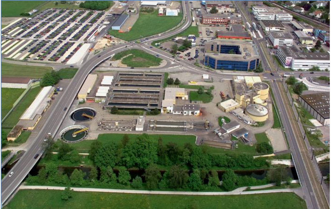
Abbildung 10: Anwendung der Pulveraktivkohle - Versuche auf der Kläranlage Kloten – Schweiz / Luftbild
