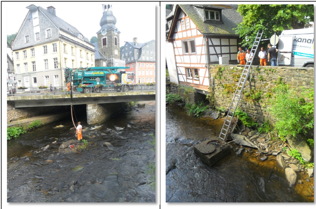
Abbildung 4: Kanalreinigung, Schacht an der Rurstraße
