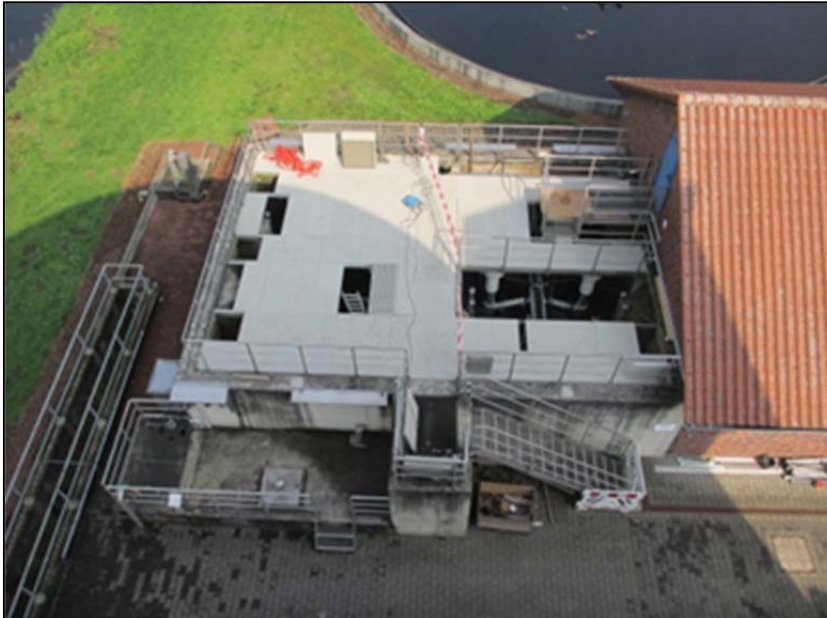
Bild 42: Dyna-Sand Carbon Filtration (KA Rietberg) (Quelle: Ingenieures. Dr. Knollmann mbH)
