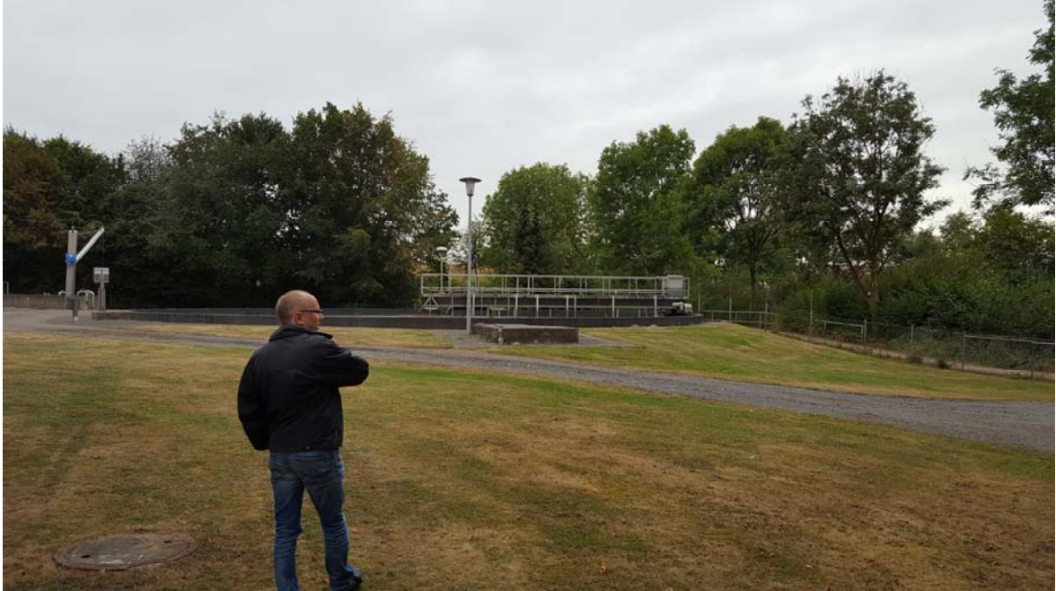
Bild 21: Möglicher Standort – 4. Reinigungsstufe (nördl. Nachklärbecken, westl. Belebungsbecken (Blick n. Süden)
