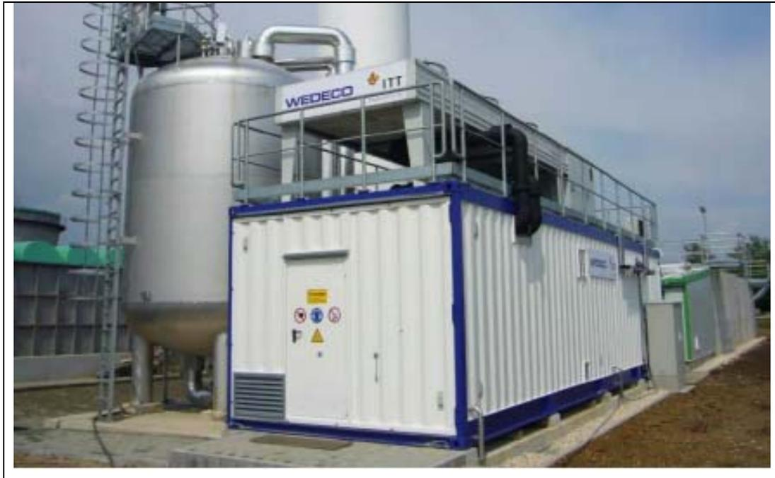
Bild 16: Beispiel Aufstellung Ozongenerator in Container (Quelle: Fa. Xylem)
