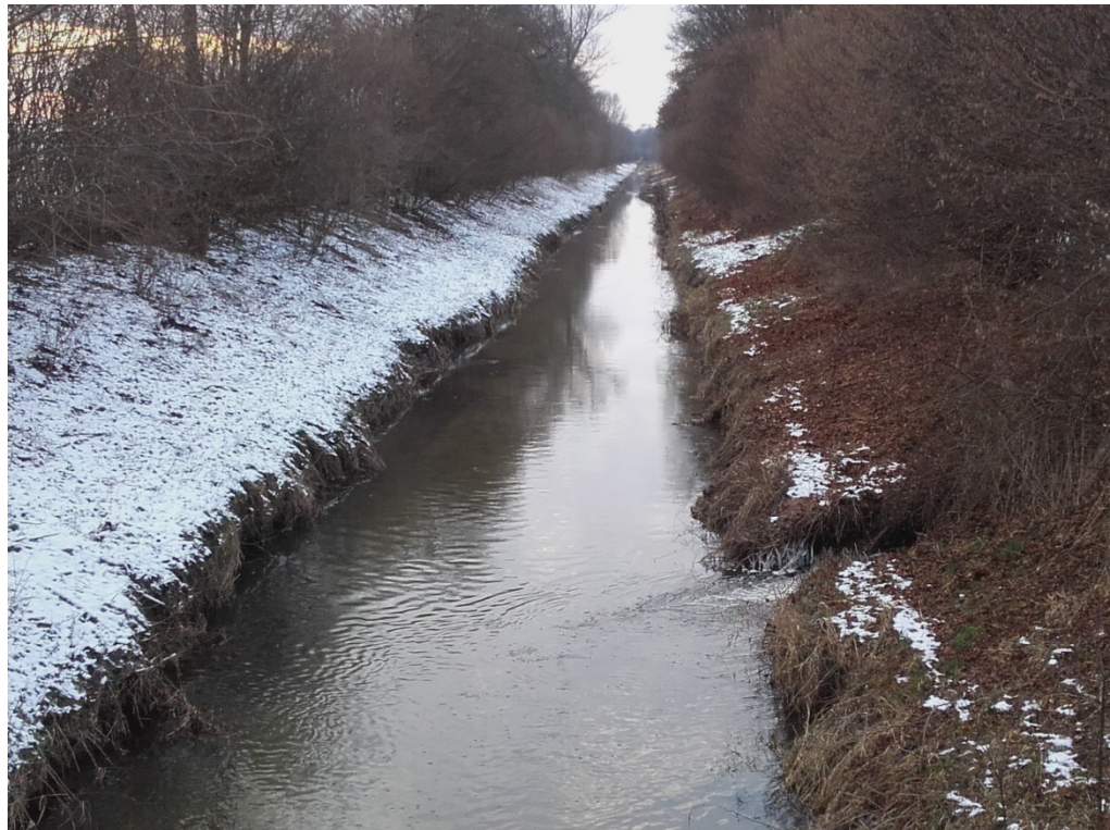
Abbildung 3-14: Einleitungsstelle der ZKW Wadersloh in den Vorfluter Liese
