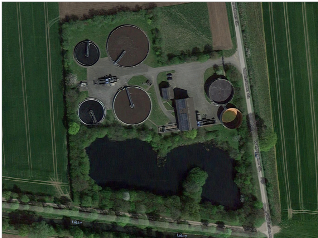
Abbildung 3-1: Luftbild der Kläranlage Wadersloh (Google Maps, 2017)
