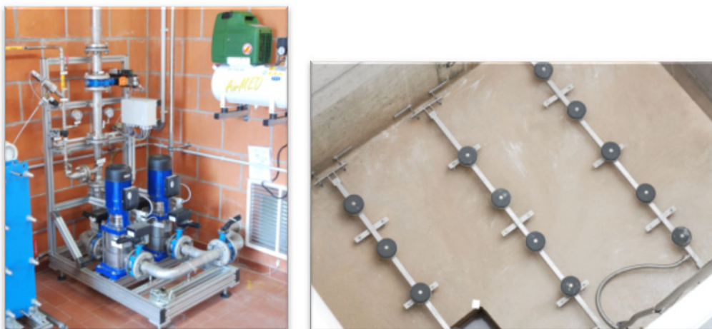
Abbildung 5.3: Ozon-Eintragungssysteme, Injektor (links) und Diffusor (rechts)
