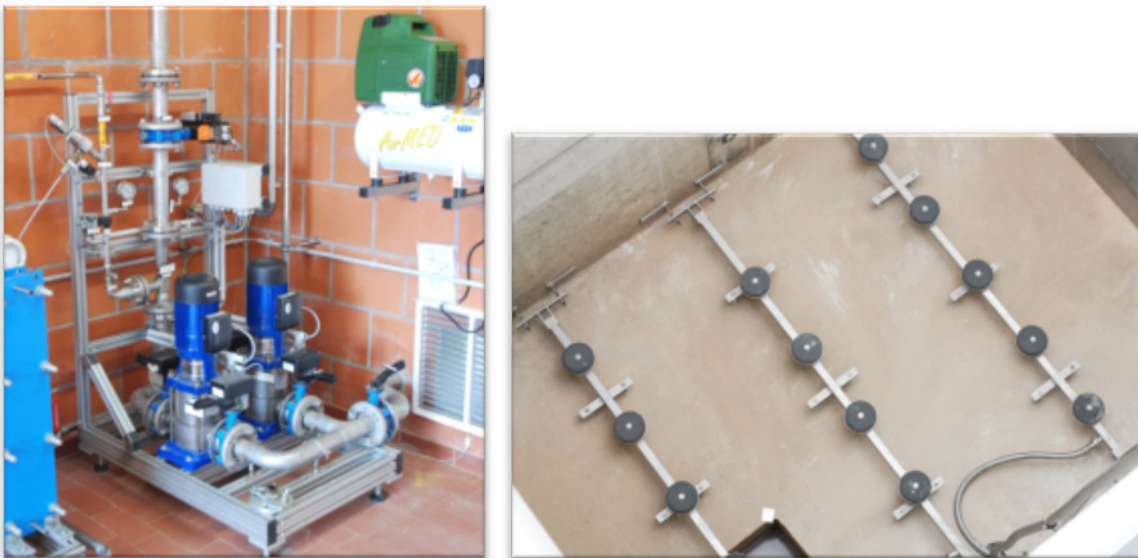
Abbildung 5.3: Ozon-Eintragssysteme, Injektor (links) und Diffusor (rechts)
