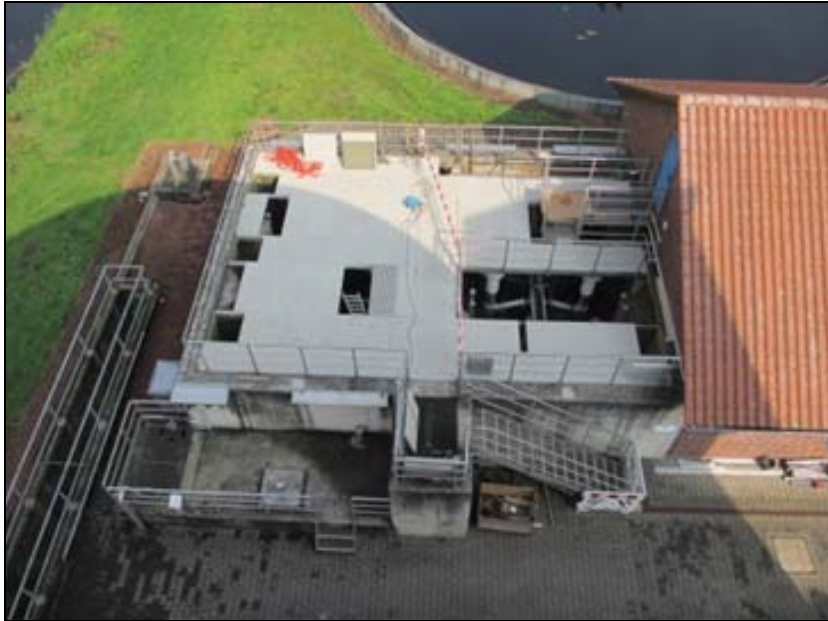
Bild 41: Dyna-Sand Carbon Filtration (KA Rietberg) (Quelle: Ingenieures. Dr. Knollmann mbH)
