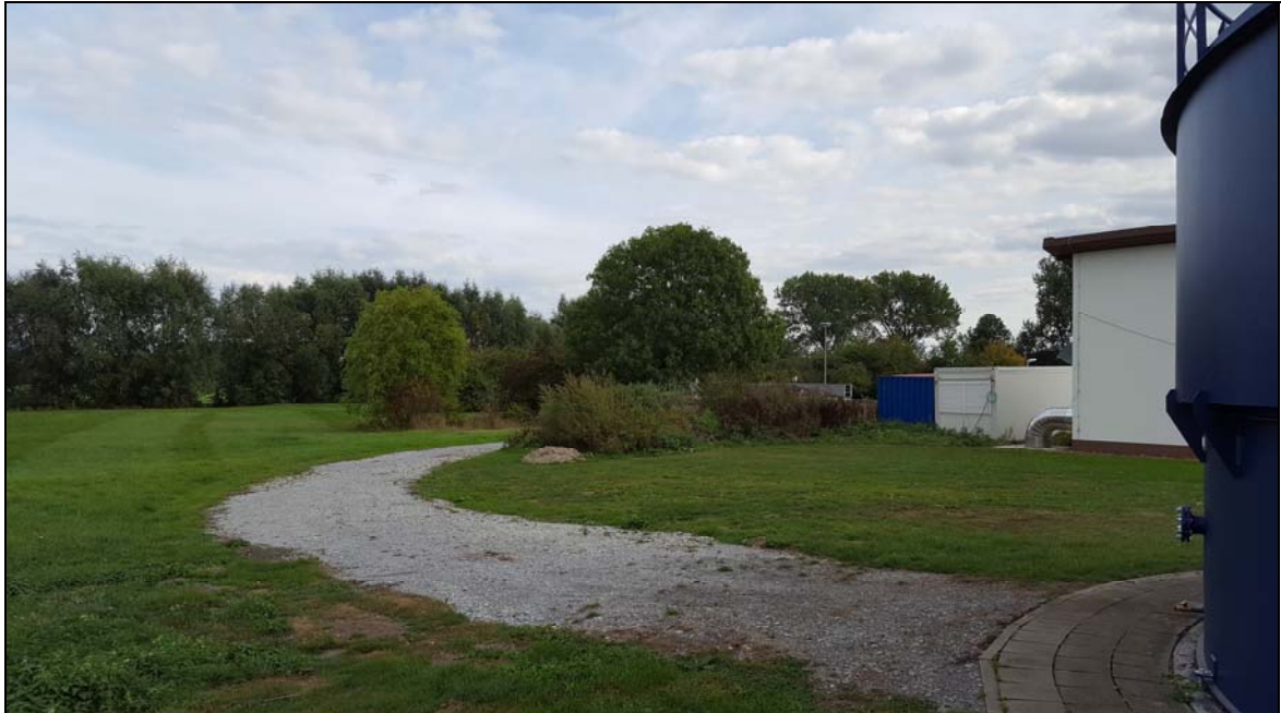
Bild 20: Möglicher Standort – 4. Reinigungsstufe (östl. Faulung, nördl. Nachklärung) (Blick n. Ost)
