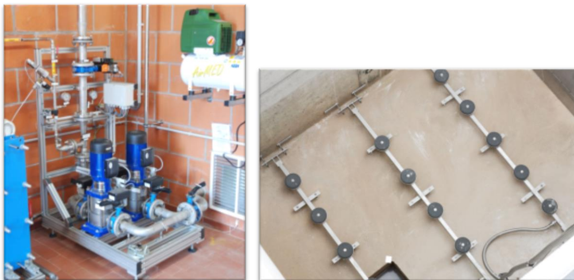
Abbildung 3-3: Ozon-Eintragungssysteme, Injektor (links) und Diffusor (rechts)
