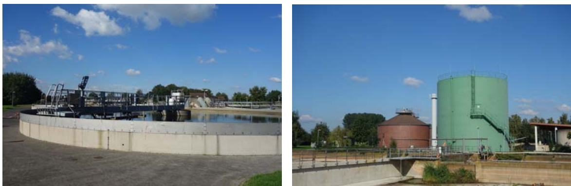
Bild 18: Nachklärung (links) , Faulung, Gasbehälter (rechts)
