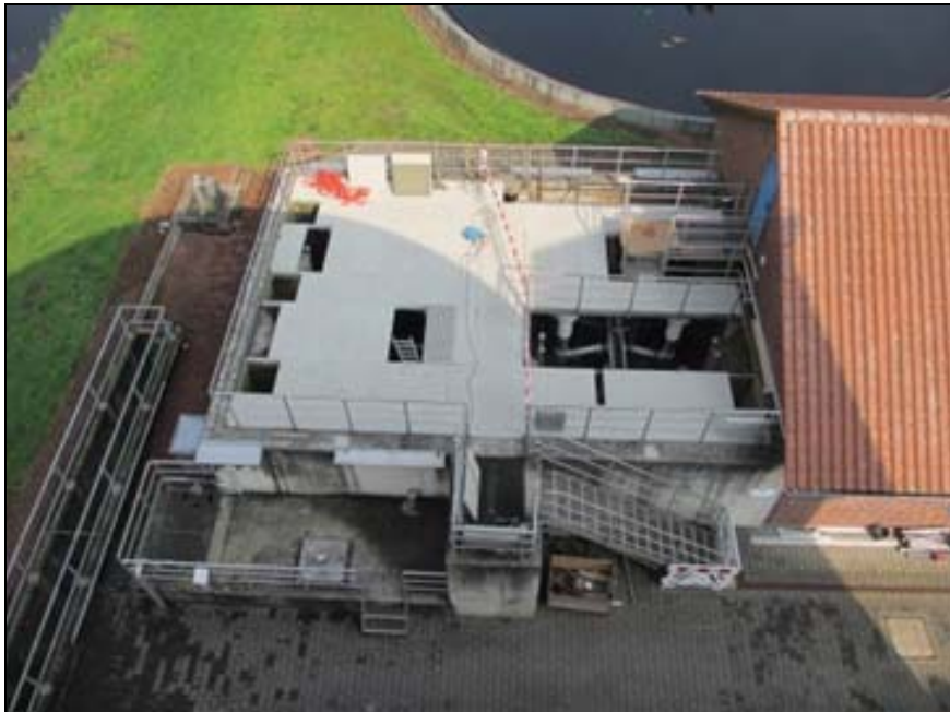
Bild 37: Dyna-Sand Carbon Filtration (KA Rietberg) (Quelle: Ingenieures. Dr. Knollmann mbH)
