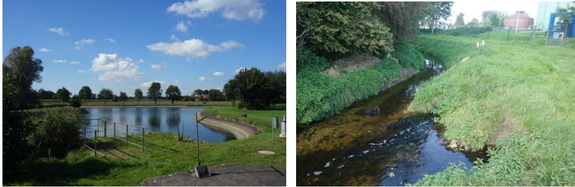
Bild 19: Schönungsteich (links), Einleitungsstelle Kläranlage (rechts)
