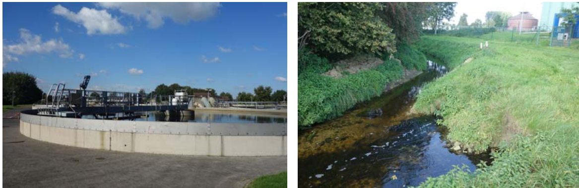
Bild 1: Nachklärung (links) , Einleitungsstelle Kläranlage (rechts)
