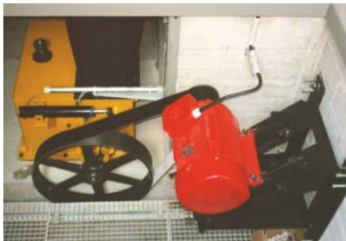
Bild 3.20: Durchströmturbine mit Generator
