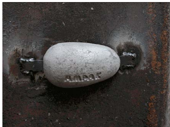
Bild 4.2: Galvanische Opferanode (MILLER, DÜCKER, 2002)
