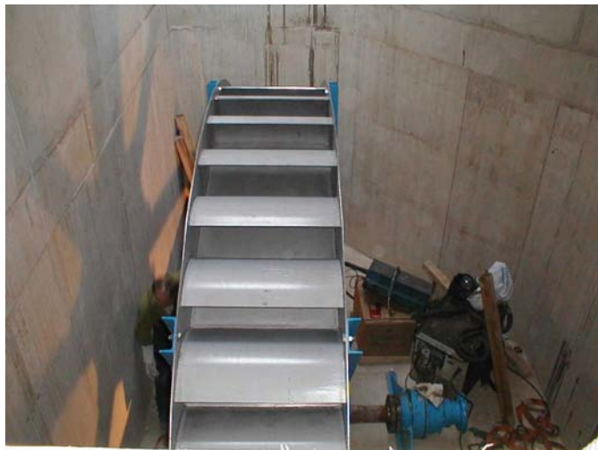
Bild 5.6: Ansicht des Wasserrades beim Einbau
