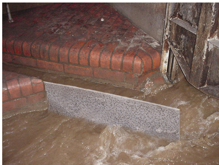
Bild 6.5: Hauptschott des Stauraumkanals und Zulaufgerinne zum Wasserrad
