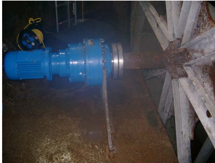
Bild 7.2: Wasserrad mit neuer Getriebe-Generatoreinheit
