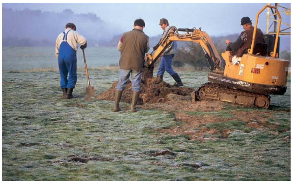
Abb. 6: Ausgraben eines großen Wildkaninchenbaues mit Hilfe eines Baggers.
