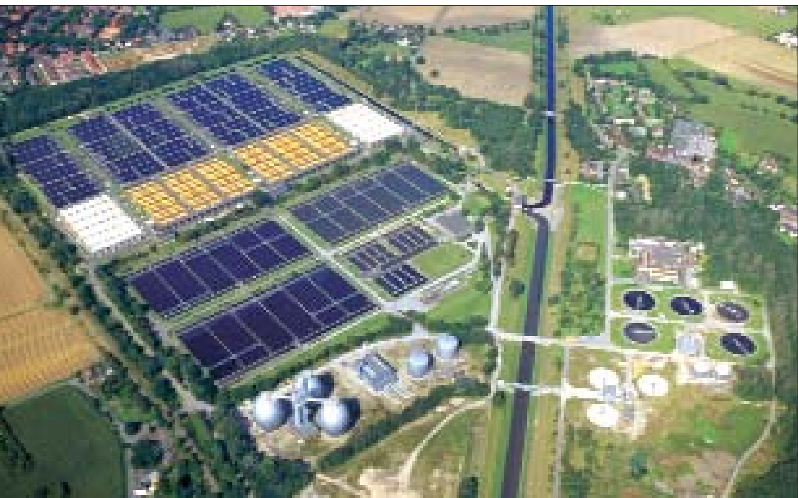
Aus braun mach blau: im Mündungsklärwerk bei Dinslaken wird die gesamte Emscher gereinigt
