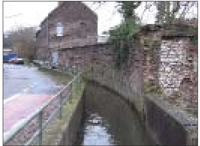
Platzmangel ist oft der Grund für Massivverbau – die Strunde in Bergisch-Gladbach
