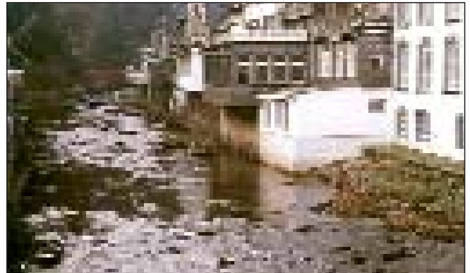
Befestigter Abschnitt des Veybachs im innerstädtischen Bereich
