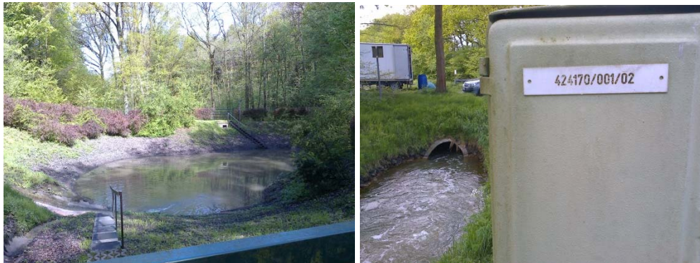
Abbildung 13: Grubenwassermessstelle und Einleitung aus dem Oeynhaus-Stollen, Foto LANUV
