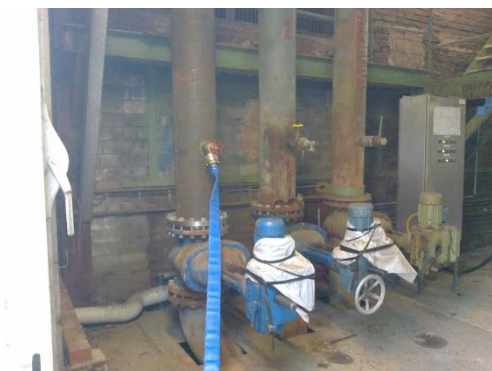
Abbildung 49: Grubenwassermessstellen und Zentrifugenprobenahme Zeche Concordia, Fotos LANUV
