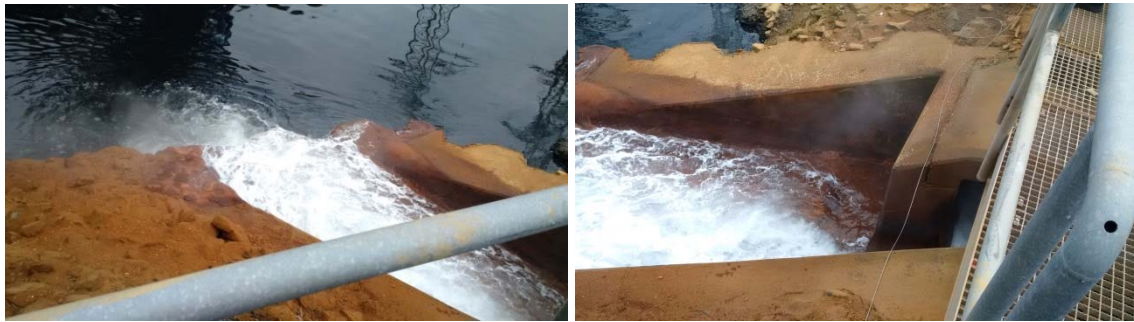
Abbildung 42: Einleitungsstelle der Grubenwässer von Zollverein in die Emscher
